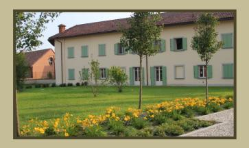
Il ripristino delle facciate con le caratteristiche cornici alle finestre, gli antelli ciechi in legno, le soglie e le zoccolature in pietra naturale, riportano all'origine l'aspetto esterno degli edifici grazie anche alle coperture realizzate in coppi antichizzati, integrati con quelli esistenti recuperati.
