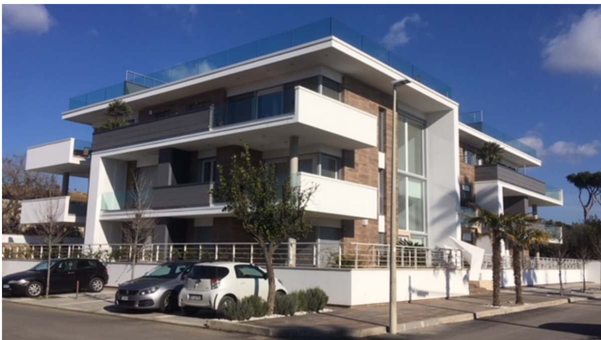
VISTA ESTERNA FABBRICATO REALIZZATO ANTERIVO 20
