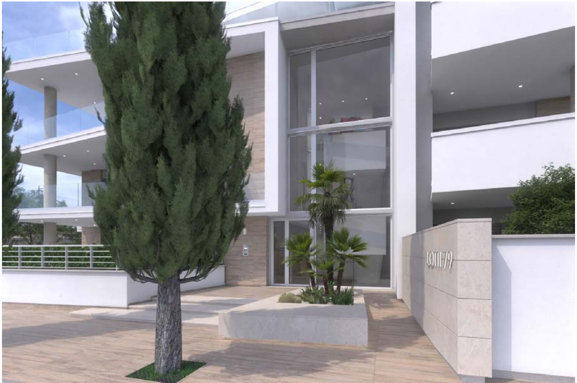
VISTA INGRESSO EDIFICIO GIA' REALIZZATO VIA LOTTI 79
