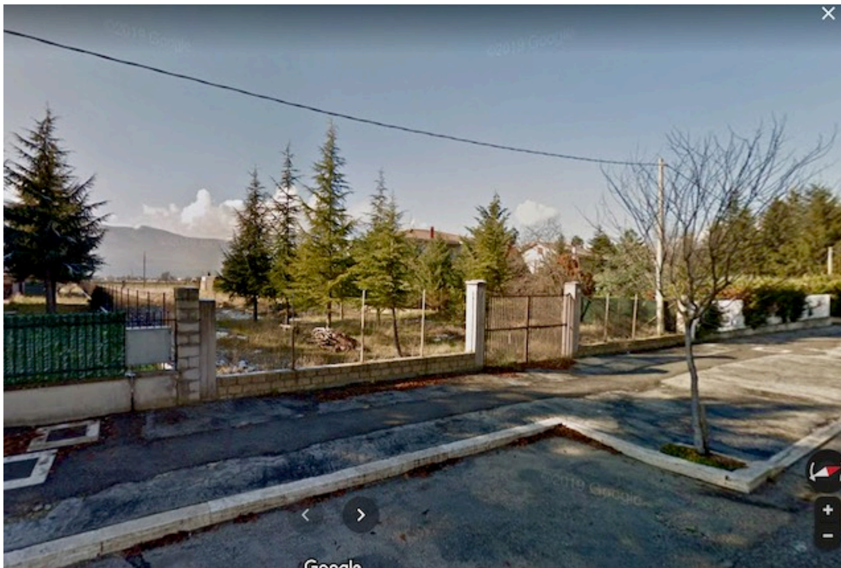
Lato ingresso - Via Cavour 106
