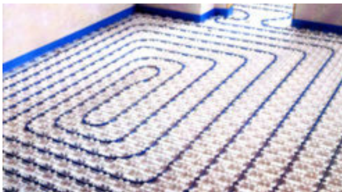
• Fig. Tubi in polietilene posati sui pannelli sagomati
