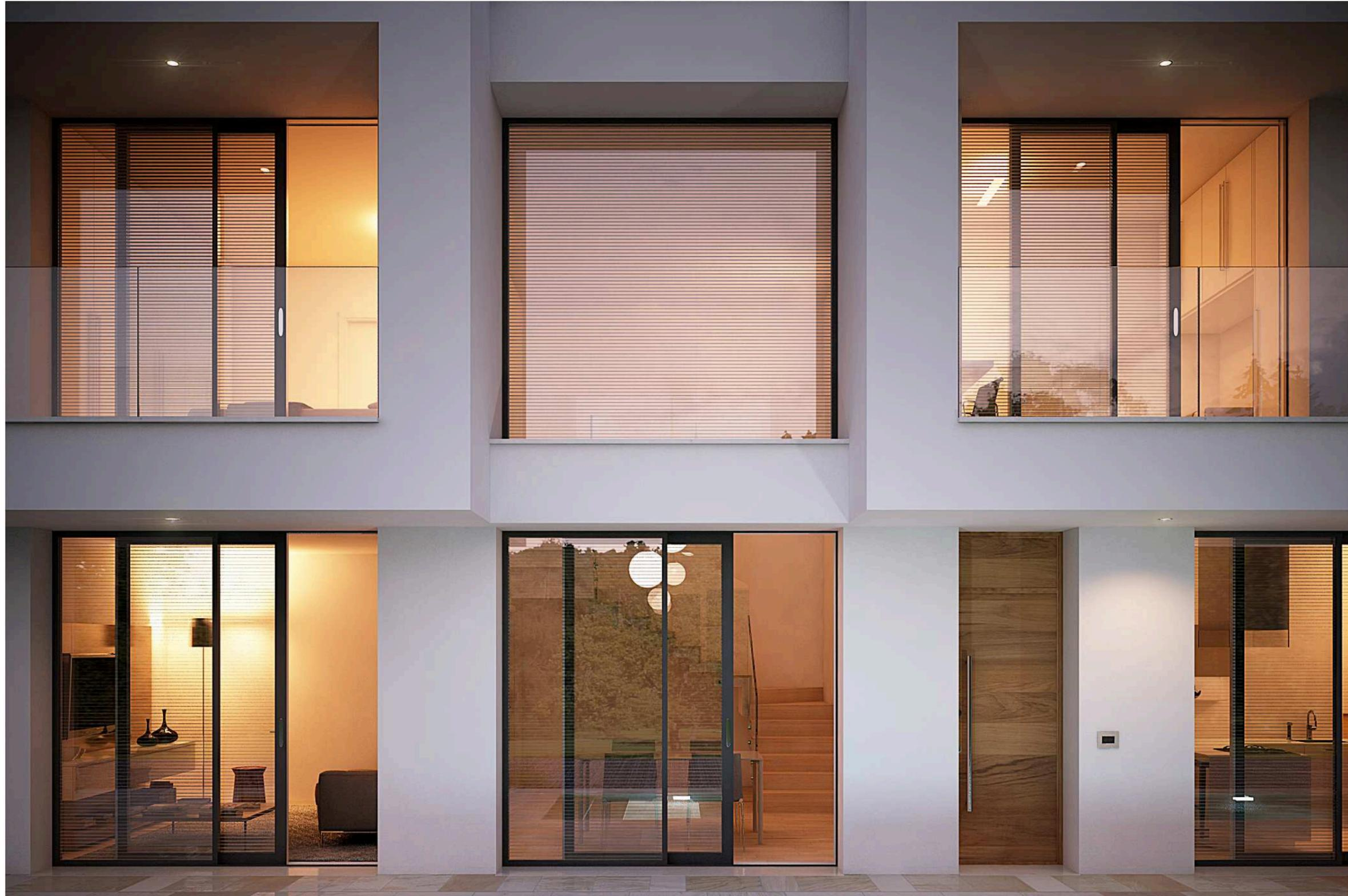
E' possibile inserire un sistema oscurante integrato con il serramento all'interno del vetrocamera , esso è costituito da una tenda orientabile a protezione dal sole e da sguardi indiscreti .
