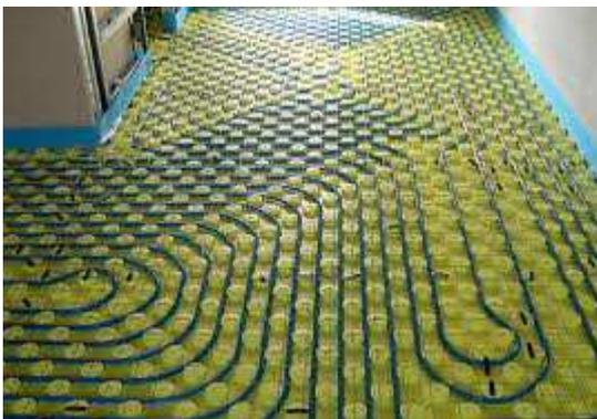
Progettato per temperature - 10°/+20° del tipo a pavimento con integrazione di un calorifero nei bagni come previsto da progetto esecutivo depositato presso il Comune di Busca. Sarà realizzata una sola centrale termica nel sottotetto nel rispetto della normativa vigente al momento della sua realizzazione. La rete di distribuzione alimenterà le singole unità abitative dotate di
