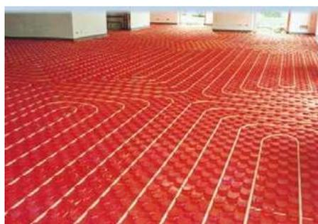
L'impianto è servito con rete in fibra superiore, pronta a ricevere il massetto di sottofondo ed incluso collaudo finale.
