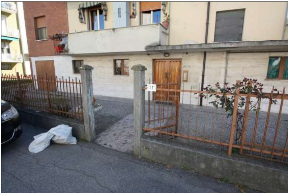
Foto n. 1: Particolare prospetto Ovest con passo pedonale su Via Cesare Battisti.
