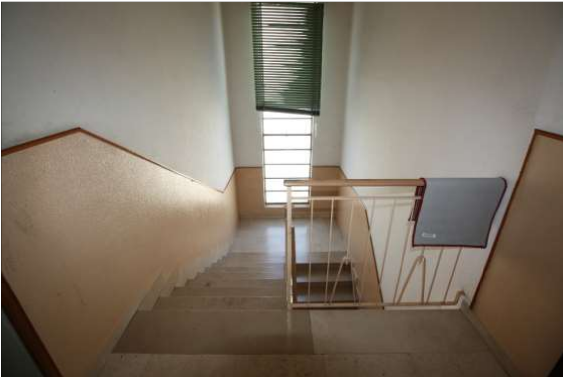
Foto n. 3: Particolare vano scala comune, di collegamento ai piani.
