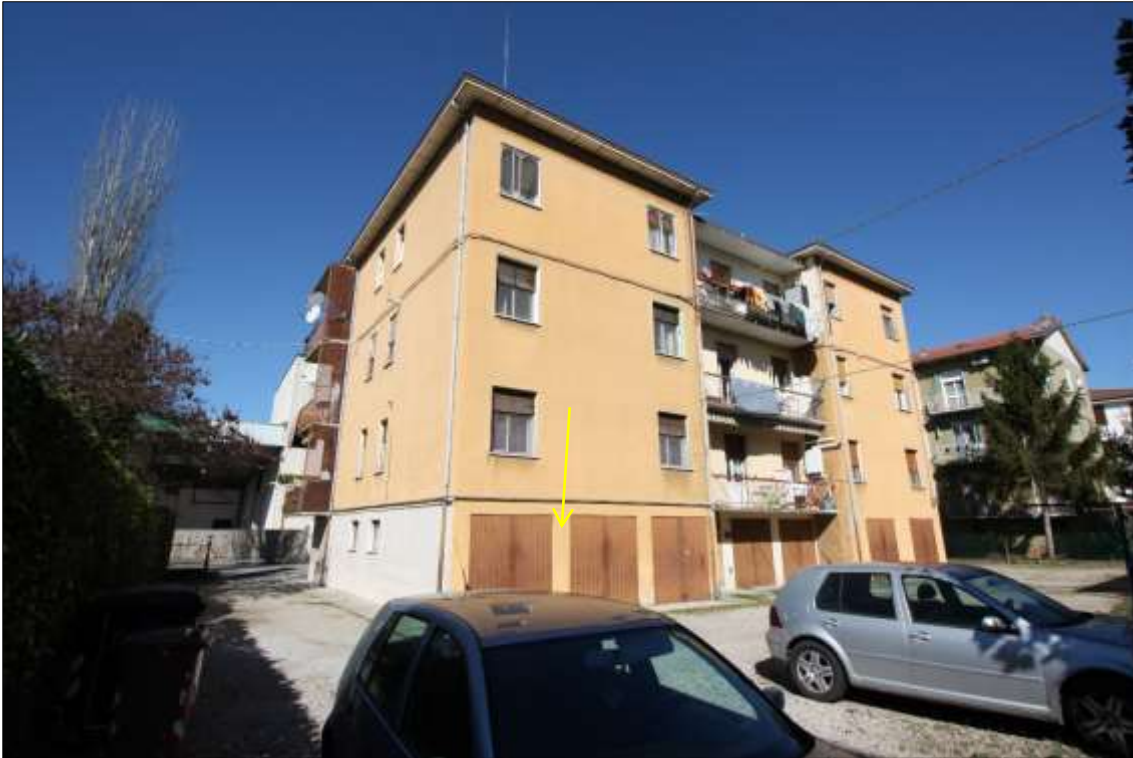
Foto n. 2: Prospetto Est con area cortiliva utilizzata per il parcheggio.
