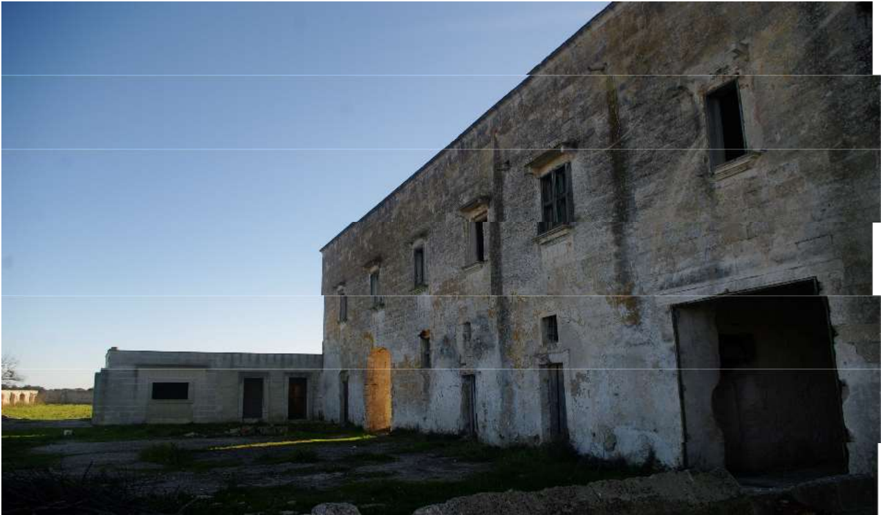
Porzione della Masseria vista da Nord. Il manufatto di fronte presentava un solaio in cemento armato (1964) che è stato demolito e ricostruito con tufi a "botte".
