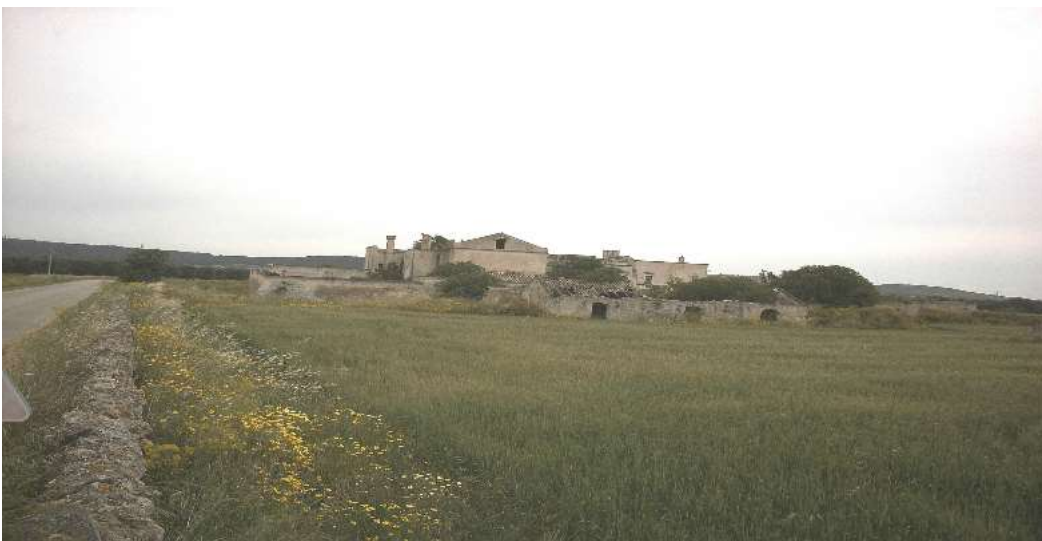
Vista da Ovest con superficie di pertinenza (a sinistra la provinciale per Taranto, Pulsano, mare, San Giorgio Jonico, Talsan, Faggiano).
