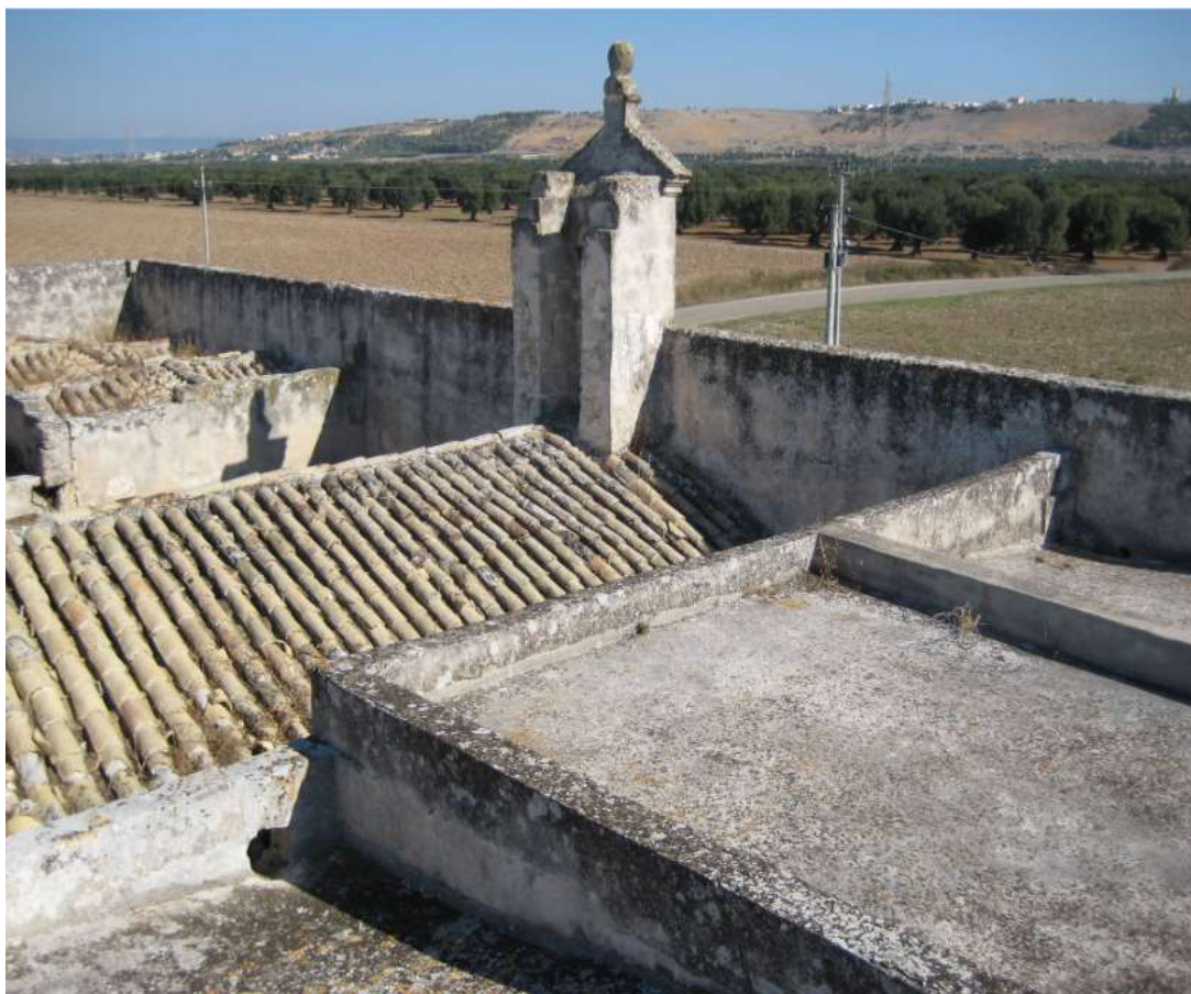
Tetti e solai. Sugli “sfondi” i Comuni di San Giorgio Jonico e il alto, a destra, quello di Roccaforzata.
