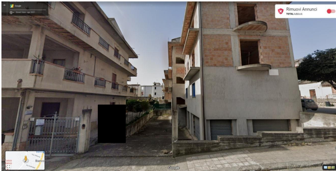
Vista fotografica prospetto laterale, lato monte, (Google Maps) - Comune Bianco, Via D. Salvadori, 25
