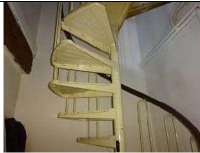
Abitazione, finiture e stato conservativo
