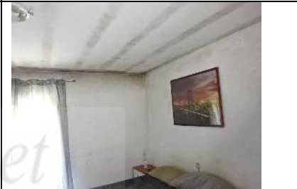
Abitazione, finiture e stato conservativo
