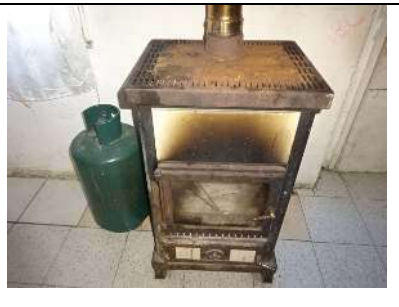
Abitazione, finiture e stato conservativo
