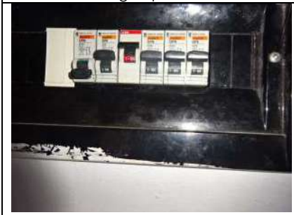
Abitazione, finiture e stato conservativo
