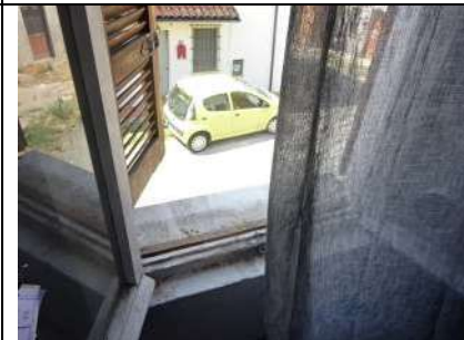
Abitazione, finiture e stato conservativo
