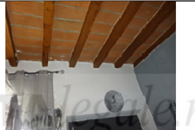
Abitazione, finiture e stato conservativo
