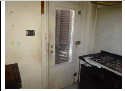
Abitazione, finiture e stato conservativo
