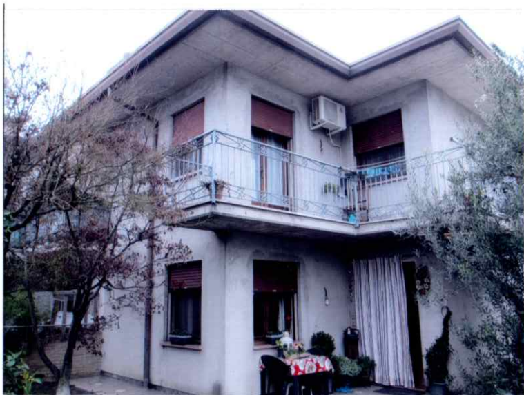
3 – Vista da SudEst dell'unità pignorata
