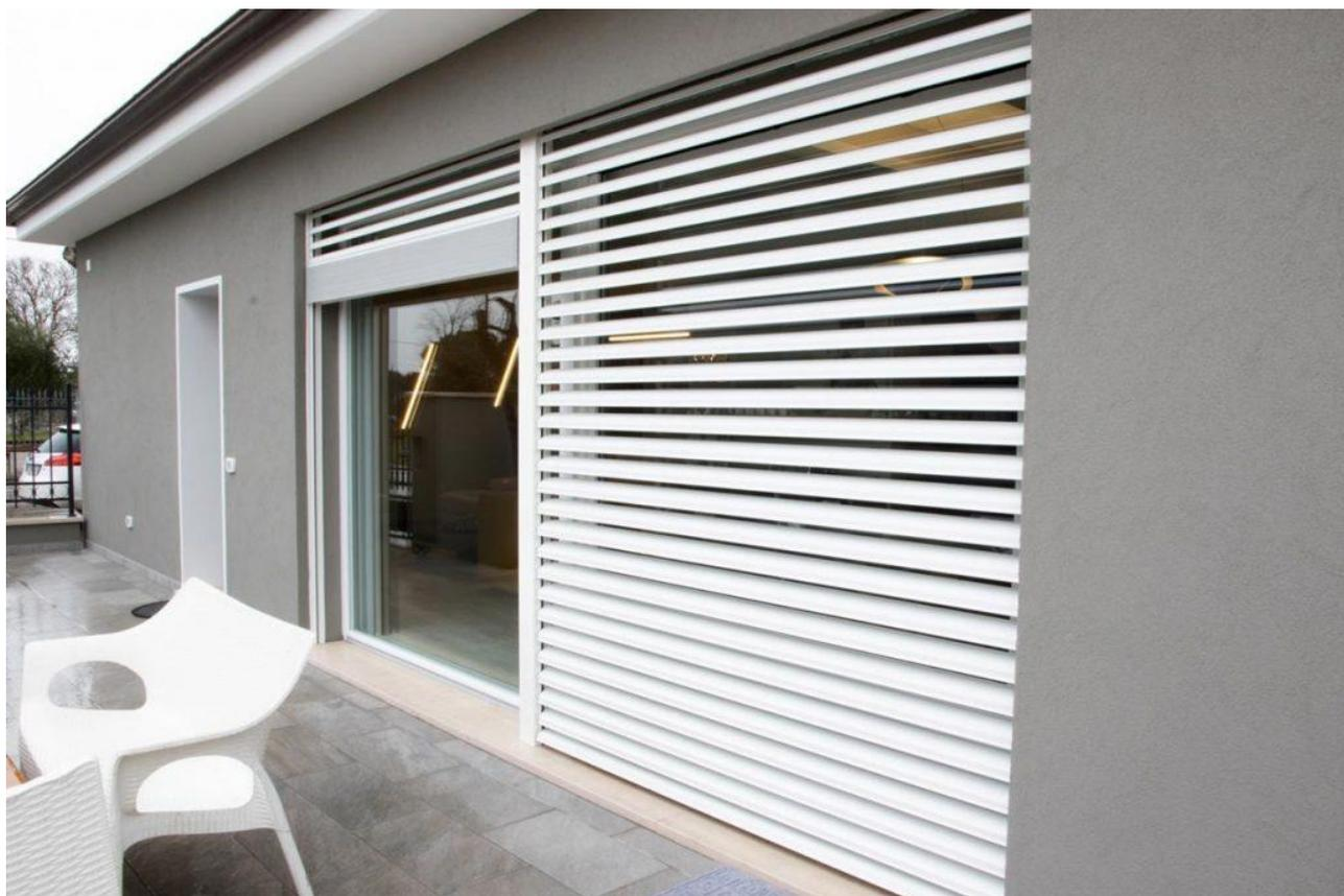
Per quanto riguarda le avvolgibili in alluminio o PVC, è prevista l'installazione di schermatura solare a caduta verticale con cassettoni esterni in luce serramento attuale (del colore scelto dalla Direzione Lavori/condominio) con sistema antieffrazione e movimentazione di sollevamento elettrico azionabili separatamente tra la porta di ingresso esterna e lo scorrevole eventuale laterale tramite telecomando elettrico e/o pulsante interno.
