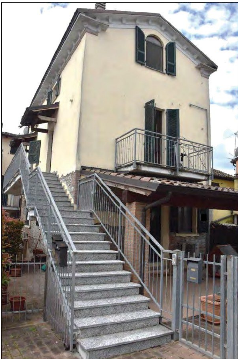
FOTO N. 2: Particolare scala di accesso al piano primo e secondo
