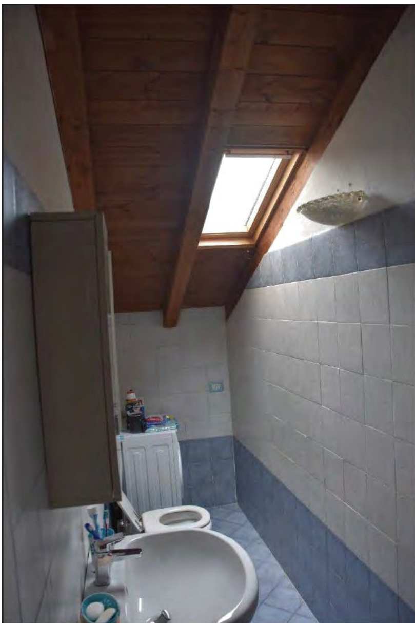
FOTO N.5: Particolare servizio igienico, unità a P.1 LOTTO 1
