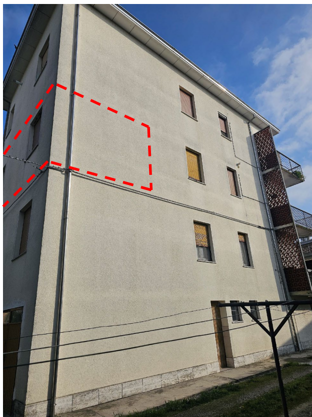
Esterno 4: Vista ovest
