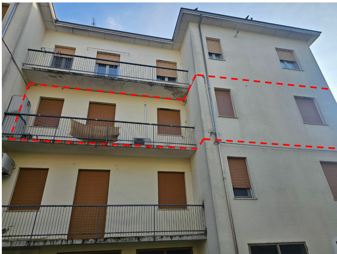
Esterno 3: Vista nord – particolare porzione in oggetto
