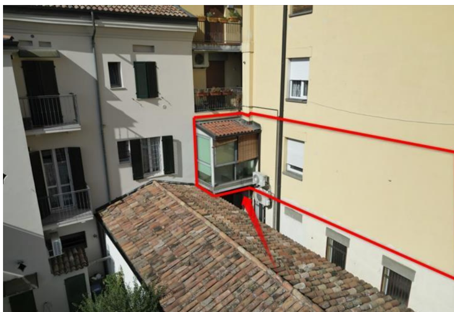
Figura 12: Esterno 3 - Prospetto Sud- Est del condominio, con indicazione della posizione dell'appartamento oggetto di pignoramento – la freccia rossa indica la posizione della caldaia posta esternamente al piano terra
