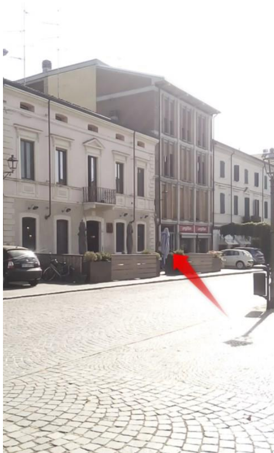
Figura 10: Esterno 1 - Prospetto Ovest – fronte principale Vista Largo Antonio Gramsci, la freccia rossa indica l'ingresso dell'abitazione
