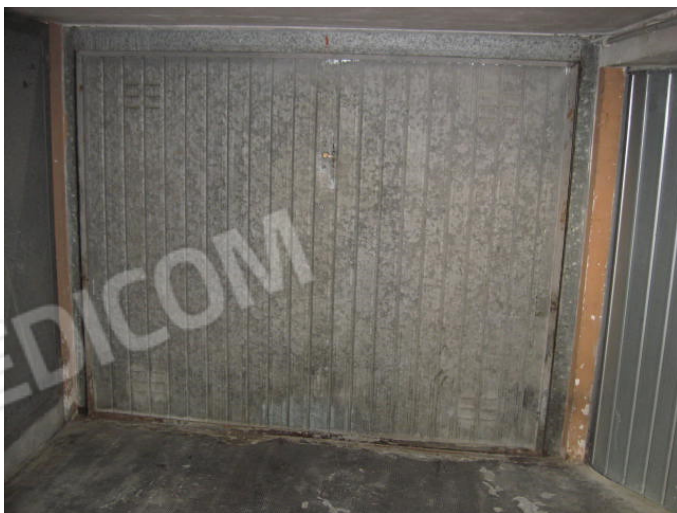
Ingresso vano cantina e parti comuni piano seminterrato
