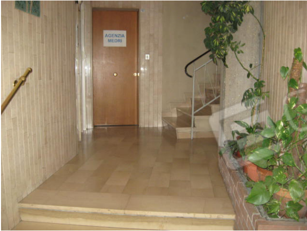
Ingresso comune piano terra e porta ascensore
