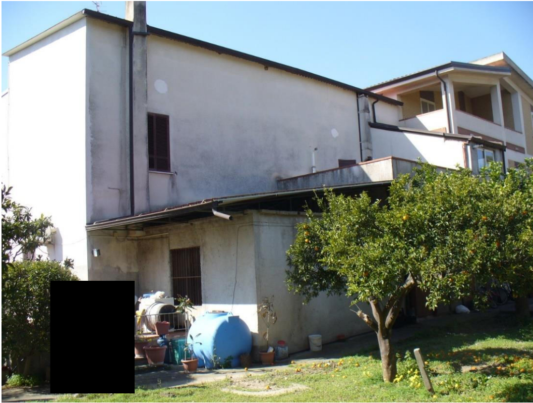
FOTO N. 9 -prospetto lato opposto a via Fossecalì-
