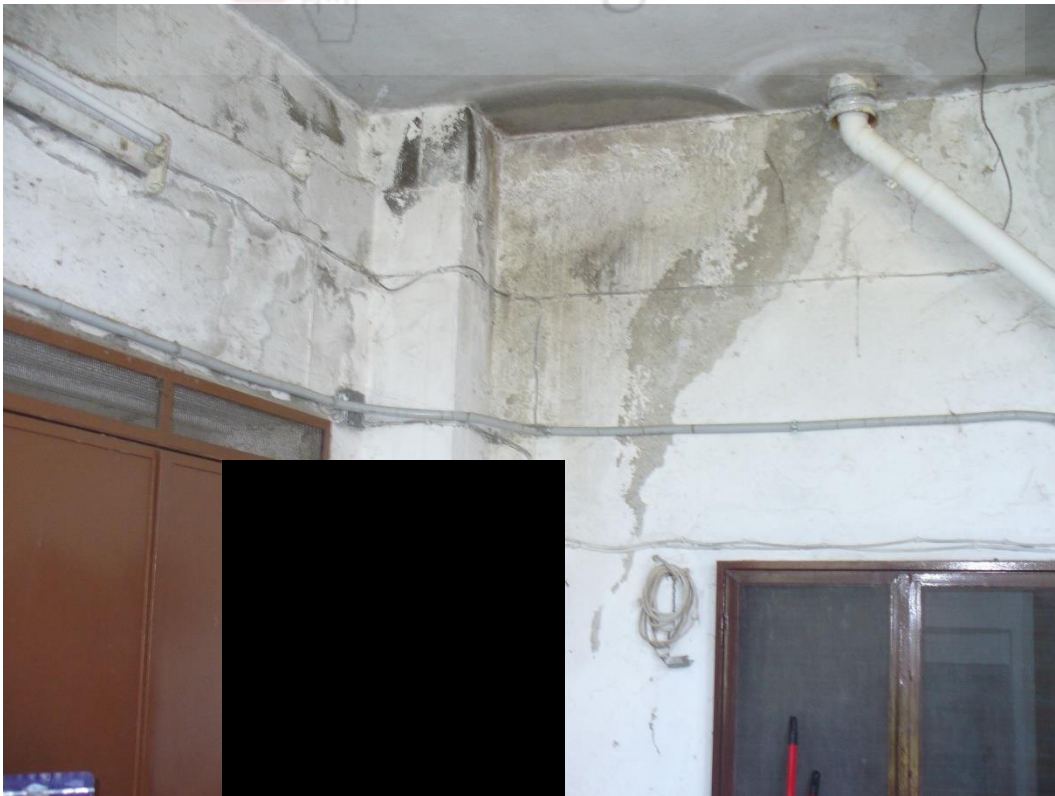
FOTO N. 16 – locale di sgombero-
