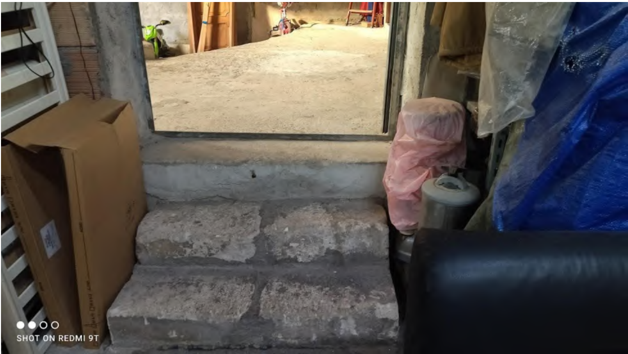
Particolare ingresso interno androne
