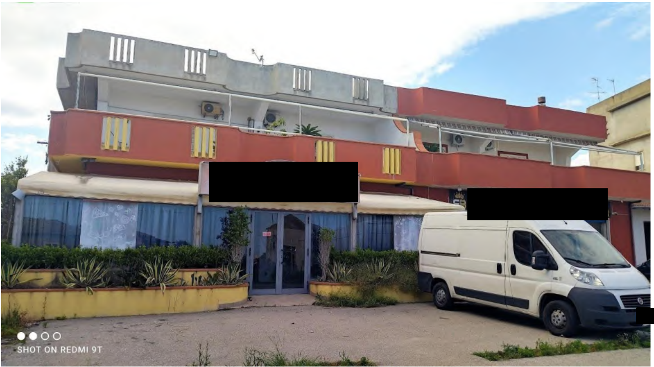
FABBRICATO PROSPETTO LATO STRADA NAZIONALE 106
