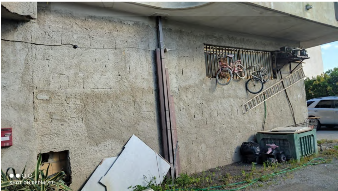
Particolare parete con finestrone
