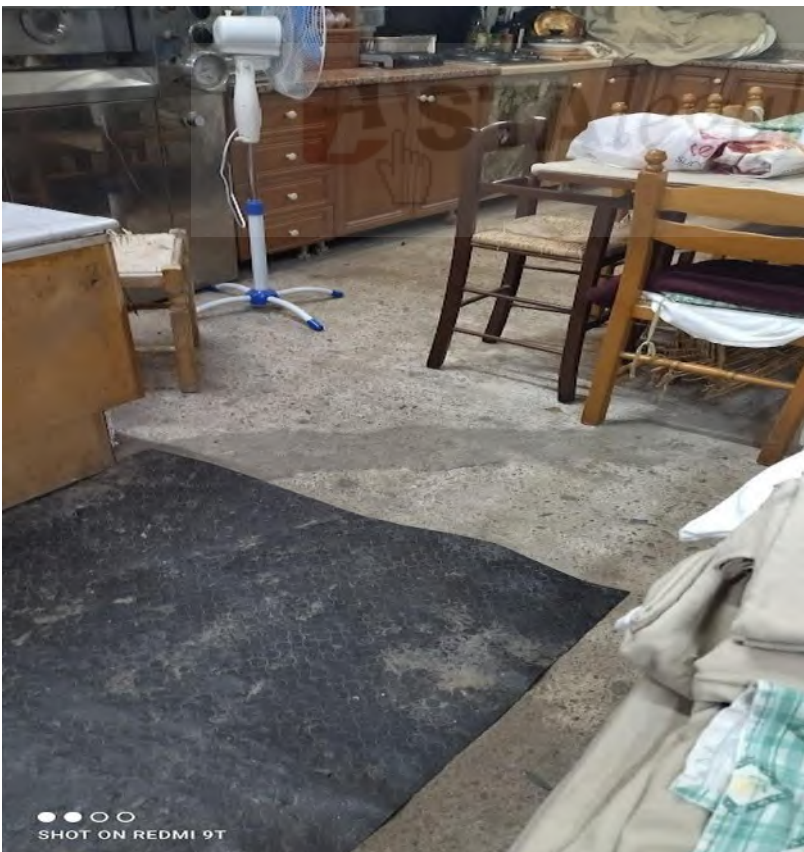
Particolare pavimento non rifinito in cls
