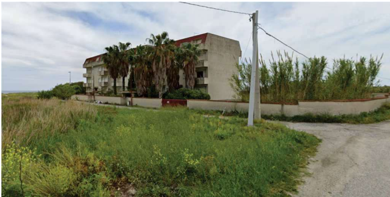
FOTO 2 VISTA GENERALE IMMOBILE
