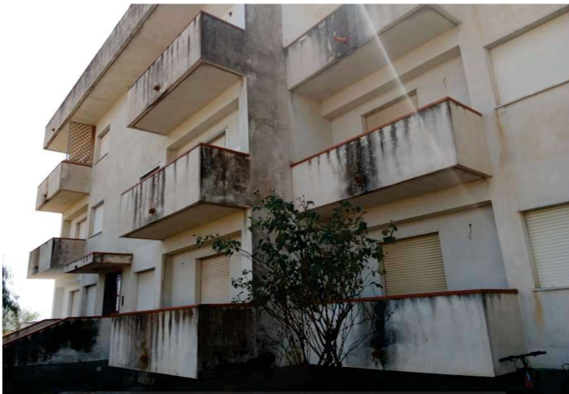
FOTO 5 PROSPETTO ANTERIORE FABBRICATO
