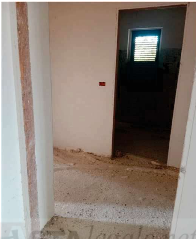
FOTO 13 INGRESSO UNITA' B
