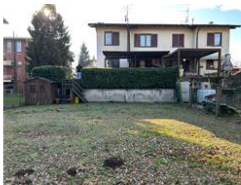
accessorio da demolire
