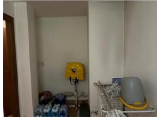
diversa disposizione muro separazione locali ripostiglio in cantina
