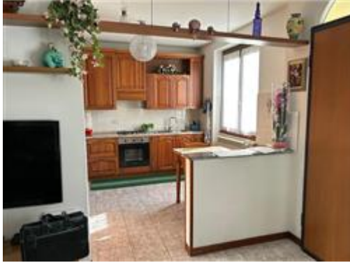
demolizione muro di separazione tra soggiorno e cucina
