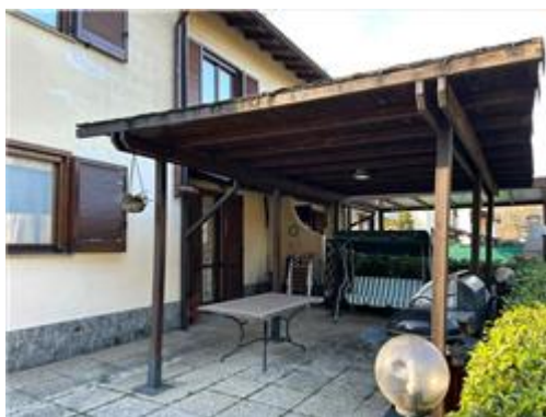
portico da demolire
