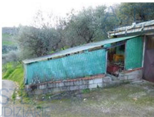
Avancorpo per cui non è stato rintracciato titolo edilizio
