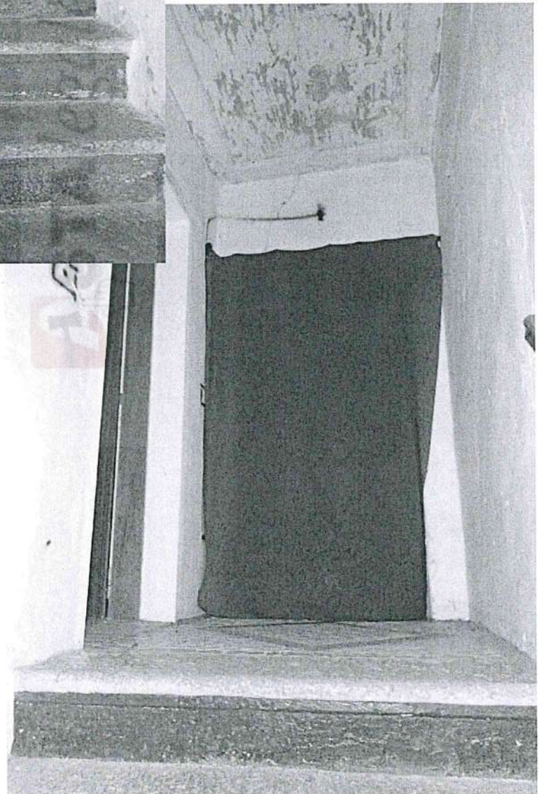
Foto 20 - pianerottolo al primo piano ed accesso al ripostiglio
