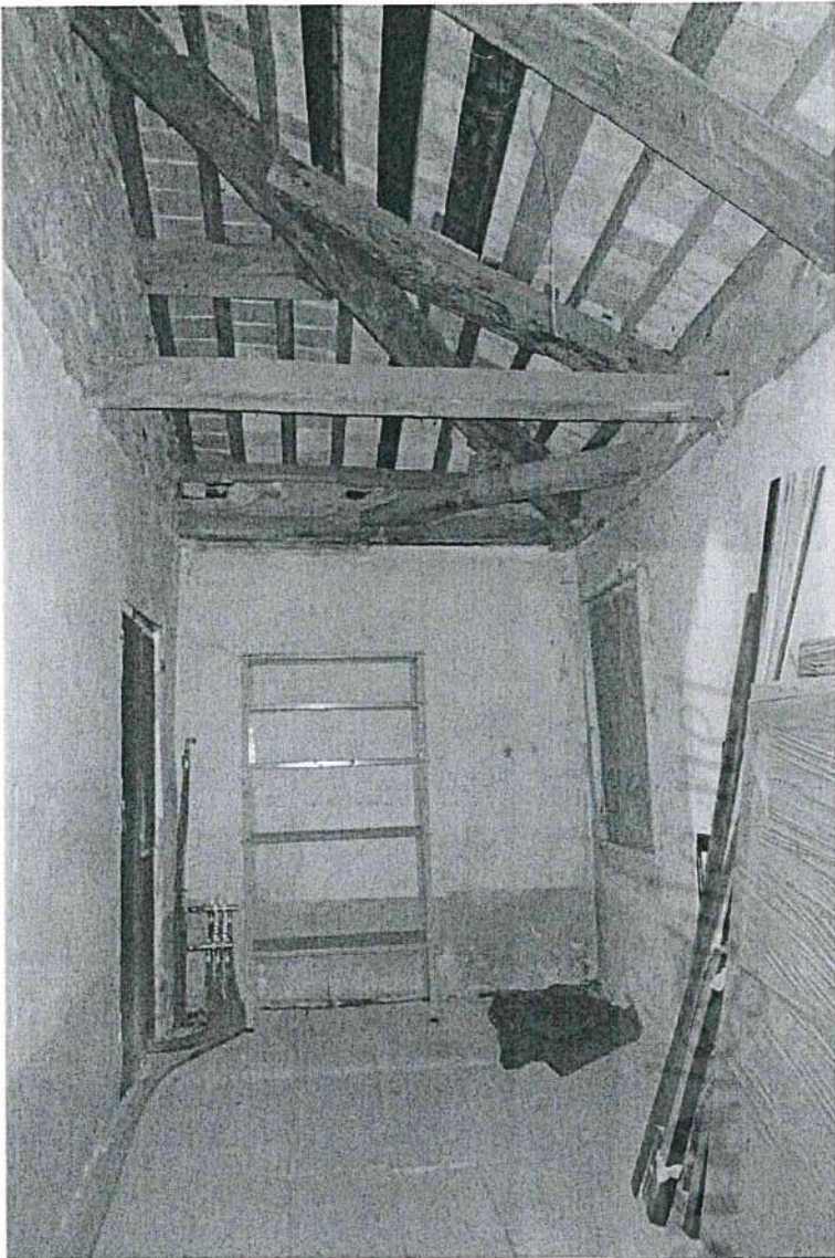
Foto 25 - Ripostiglio al primo piano
