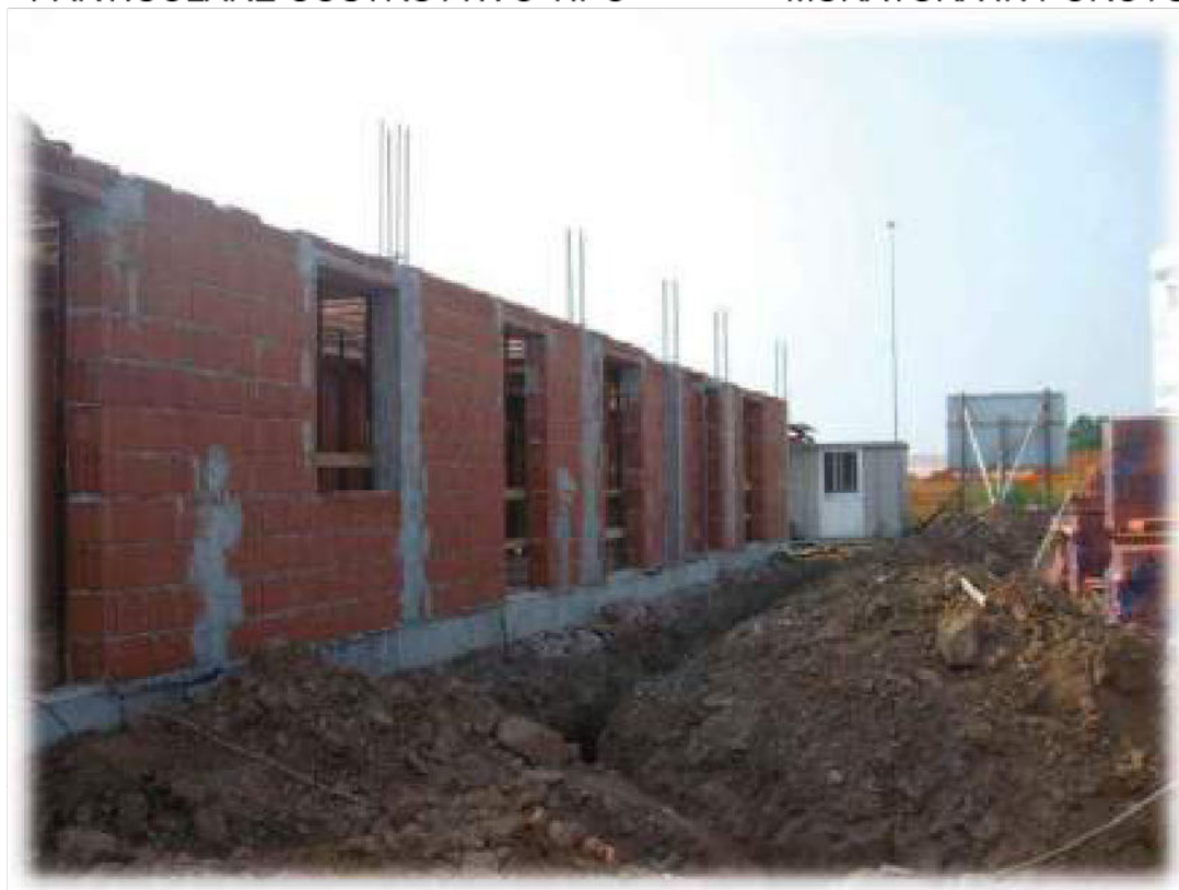
STRUTTURA PORTANTE "MISTA"
