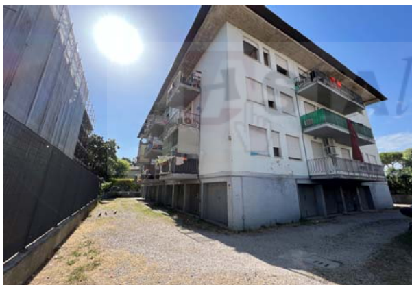
Ripresa prospetto sud ovest
