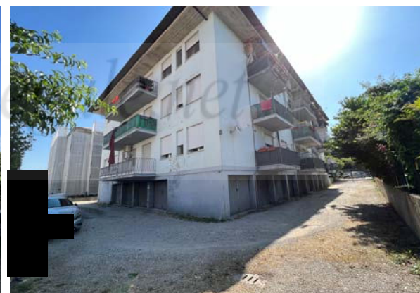
Ripresa prospetto sud ovest
