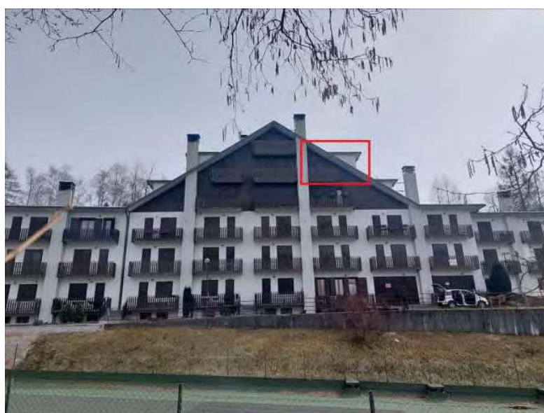
Condominio Ginestre A - Visto da nord-ovest (delimitato in rosso l'appartamento)
