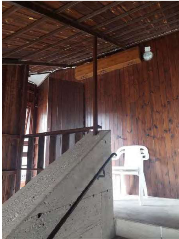
Pianerottolo con ingresso (int. 54)
