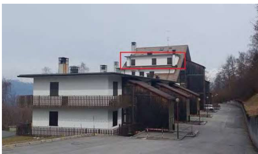
Condominio Ginestre A - Vista da Sud (delimitato in rosso l'appartamento)
