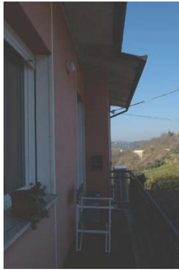
veduta del balcone con accesso dal corridoio, lato porta di ingresso
