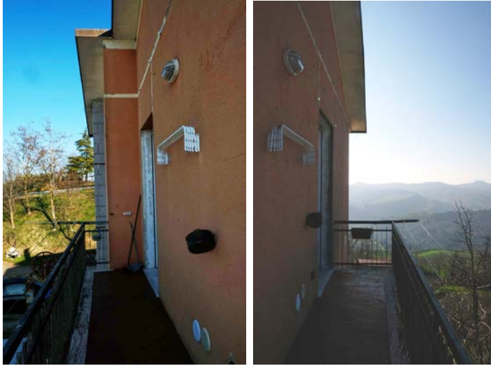
veduta del balcone al quale di accede sia dal soggiorno che dalla cucina
