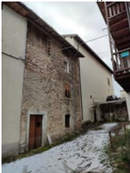
prospetto Nord con ingresso secondario
