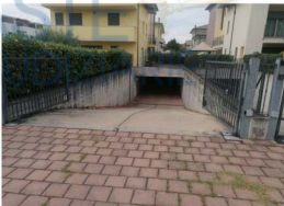
Vista del fabbricato condominiale dalla pubblica via Tasso
