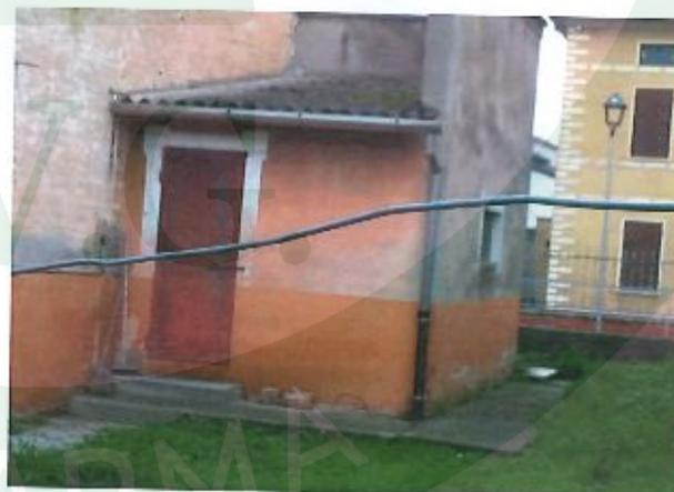
Le facciate sono finite con intonaco al civile per esterni con relativa tinteggiatura rosso nella zoccolatura inferiore e chiaro nelle facciate ormai sbiadito, vani finestre con accento di decorazione in rilievo, scuri in legno e davanzali in cemento, lattoneria in acciaio e manto di
