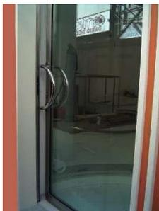
Il portoncino a piano terra di accesso alle unità immobiliari sarà realizzato in profili di alluminio e vetrocamera isolante, dotato di maniglia ed elettroserratura.
