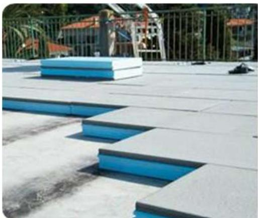
costituito dalla posa in opera di barriera al vapore e successiva posa in opera di pannelli isolante (con spessore come previsto da Legge 10) fissati meccanicamente grazie ad appositi tasselli. Eventuali modifiche esecutive non altereranno le caratteristiche qualitative proposte nella soluzione descritta.
