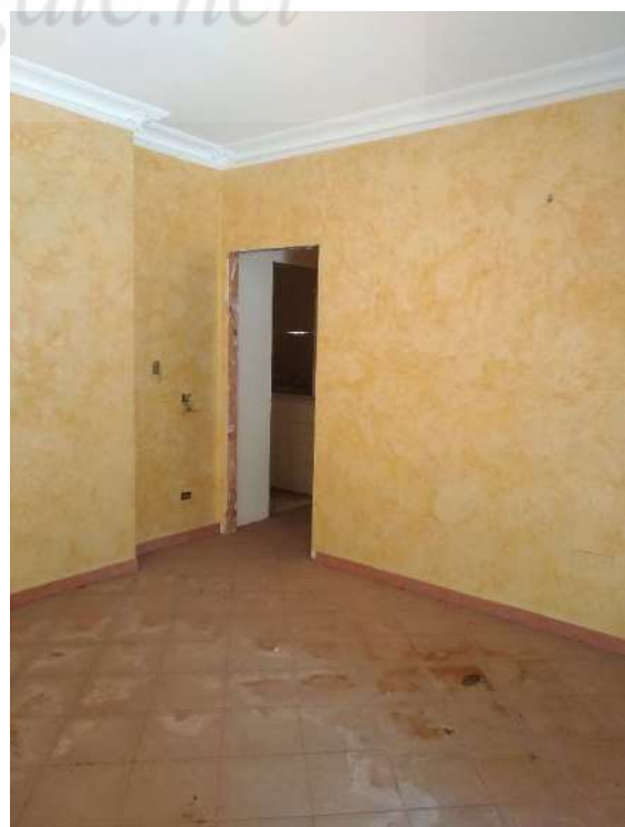
FOTO 23 VANO 10 PIANO SECONDO
