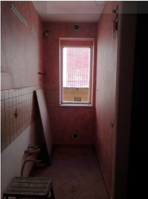
FOTO 20 VANO 7 PIANO PRIMO
