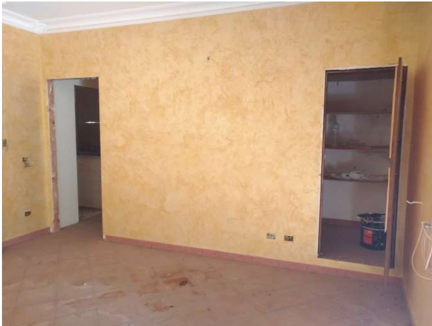
FOTO 24 VANO 10 PIANO SECONDO
