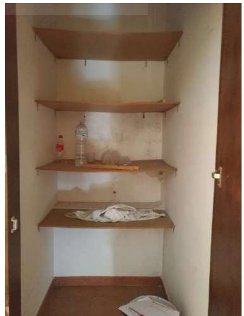
FOTO 26 VANO 11 PIANO SECONDO
