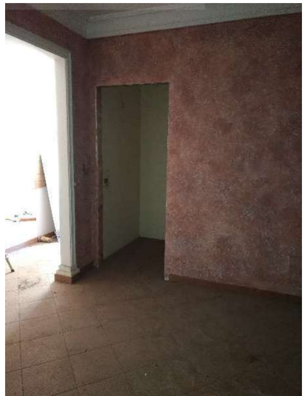
FOTO 14 VANO 6 PIANO PRIMO
