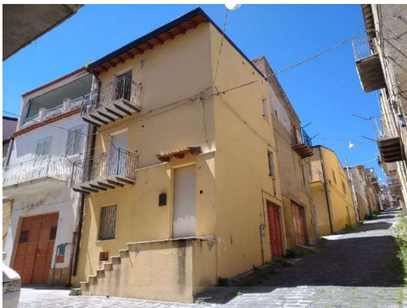
FOTO 1 – PROSPETTO via FARACI angolo via PALAZZO
