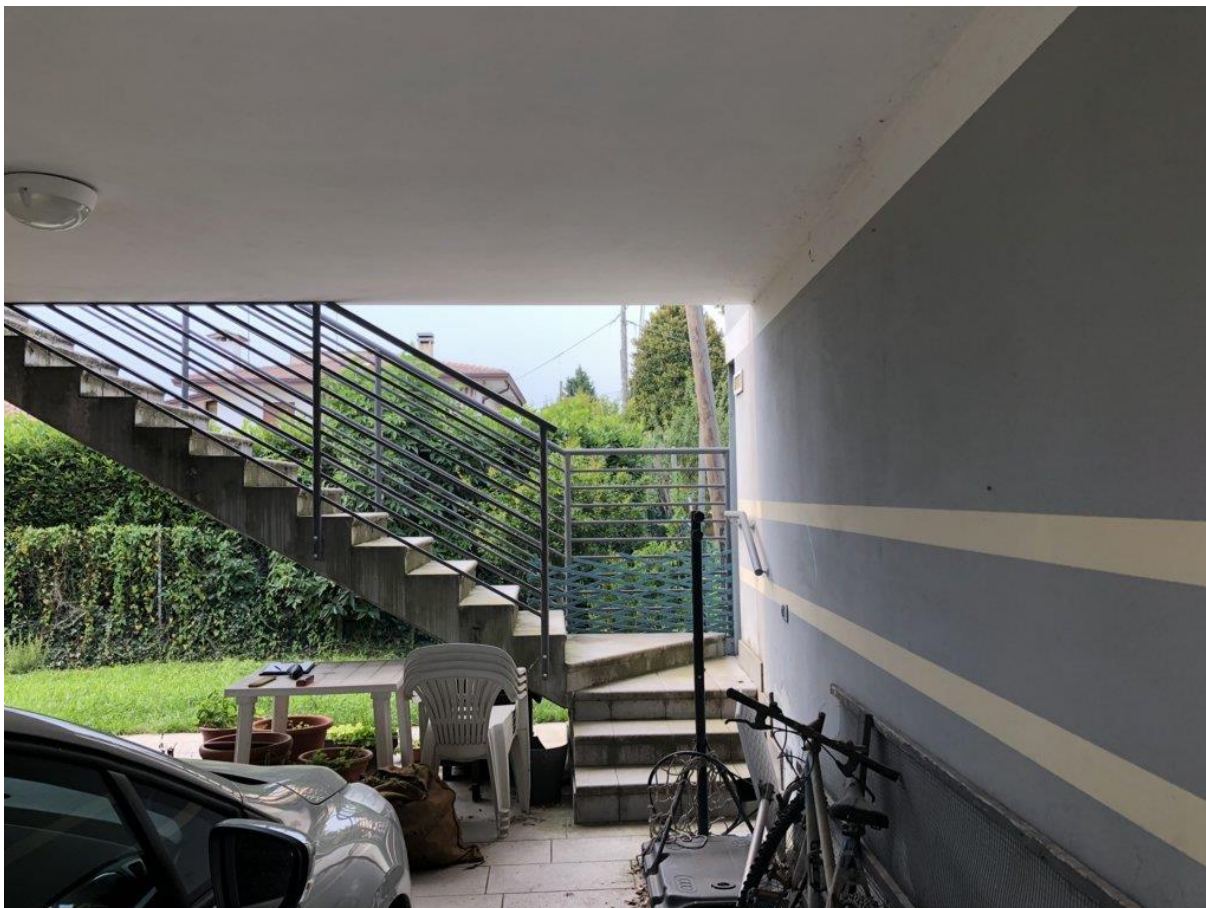
foto n. 27 – garage pignorato (sub. 24) e scala esterna
