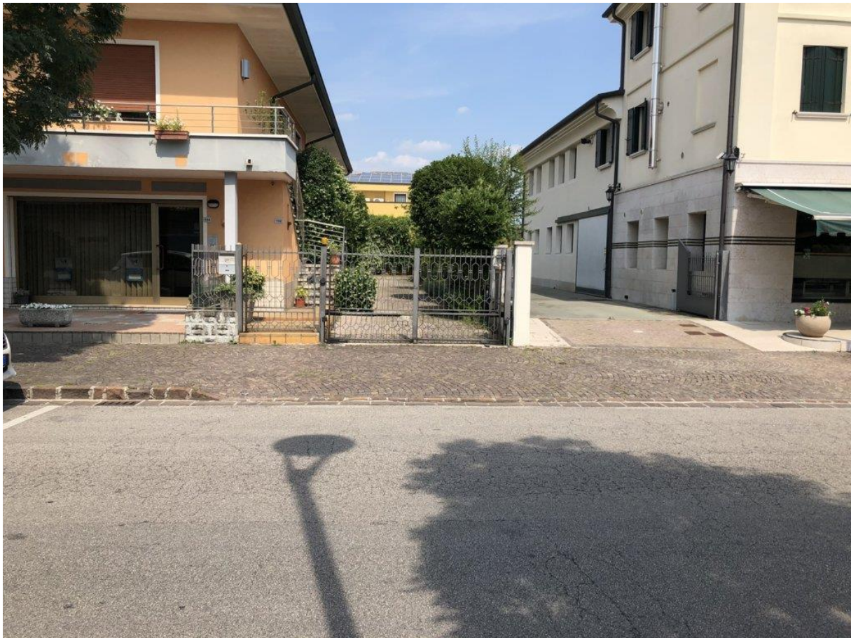
foto n. 3 – ingresso al fabbricato
