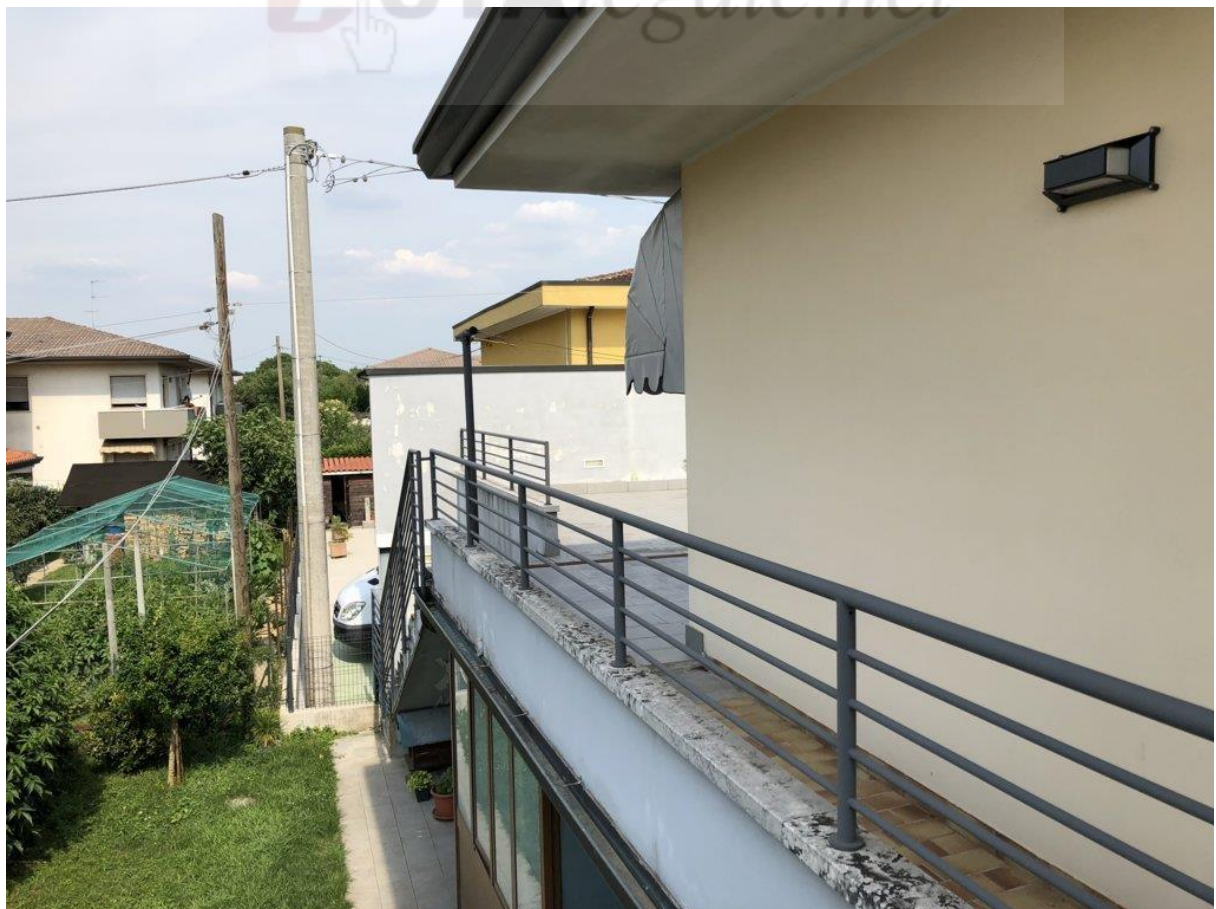
foto n. 18 – poggiolo piano primo lato nord
