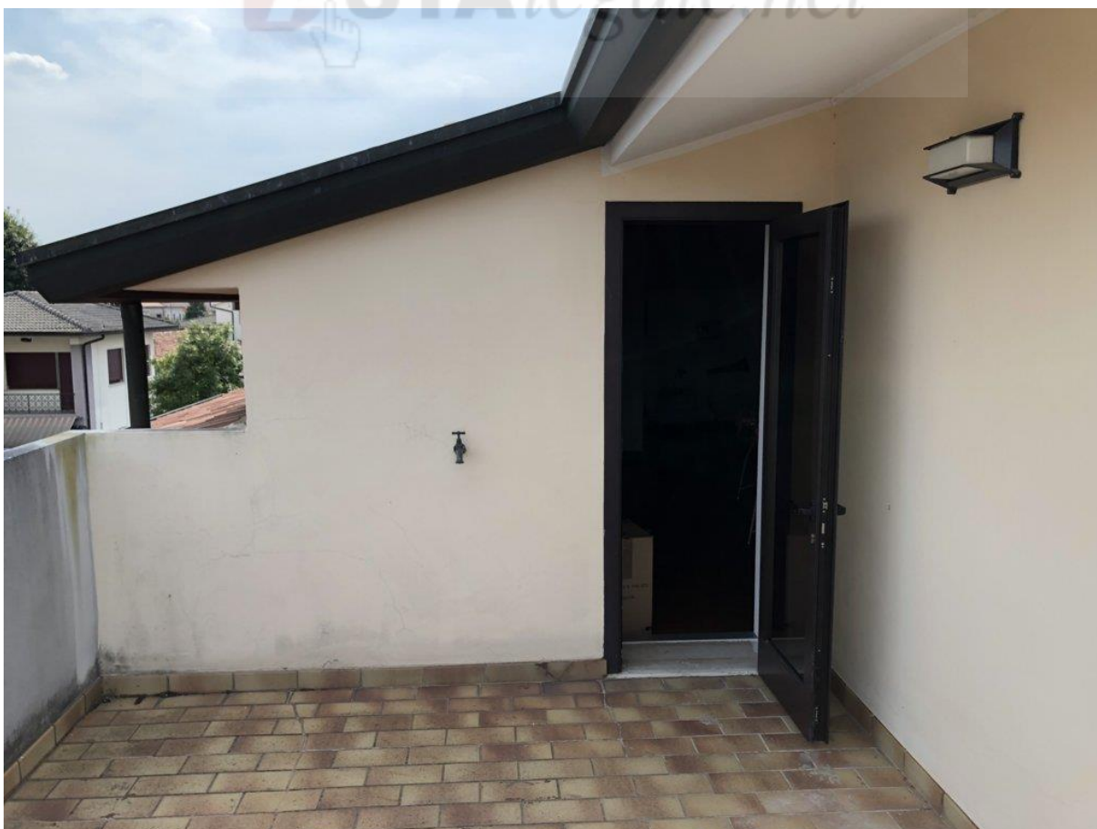
foto n. 22 – terrazza a piano secondo
