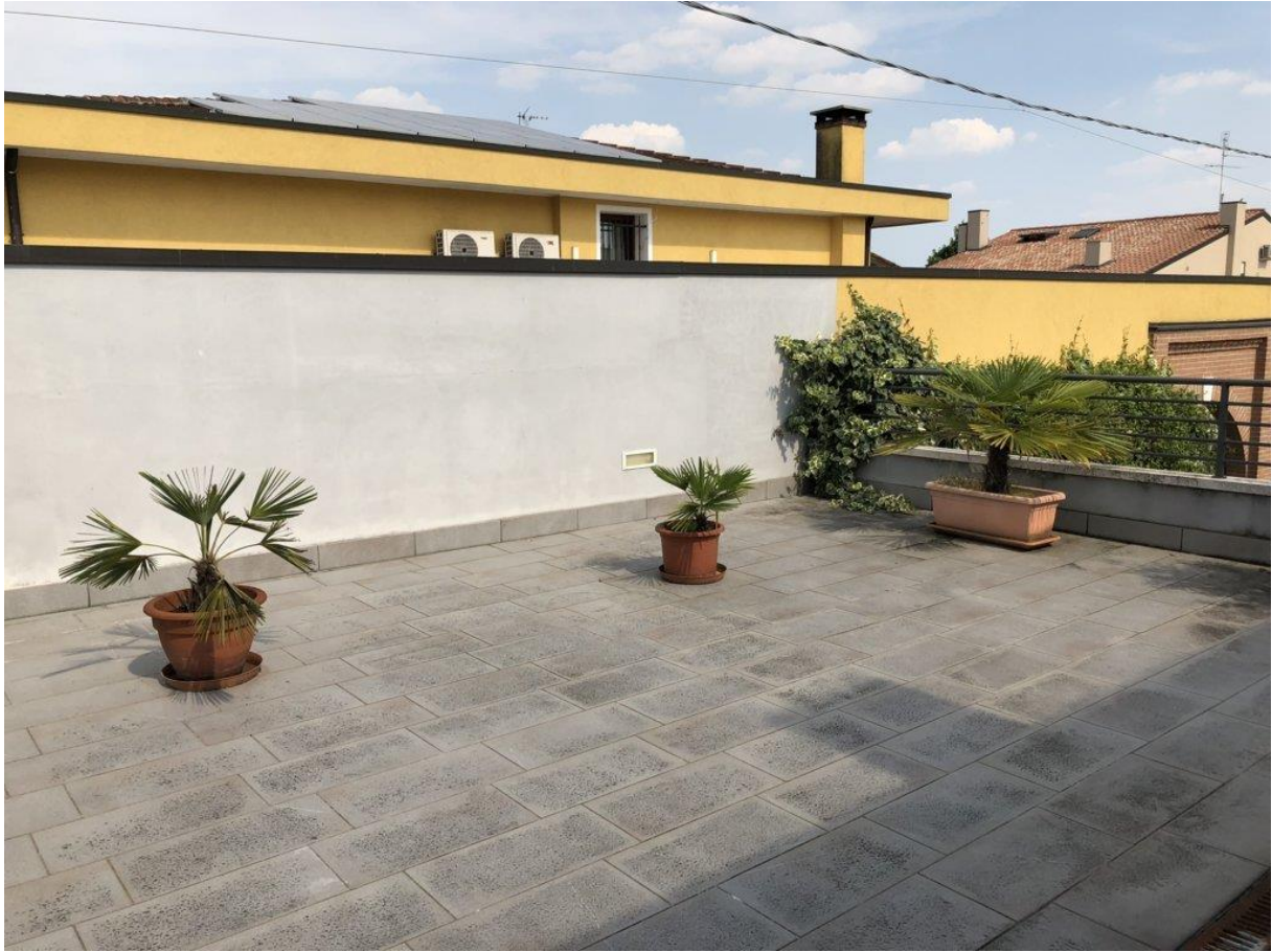
foto n. 17 – terrazza a piano primo
