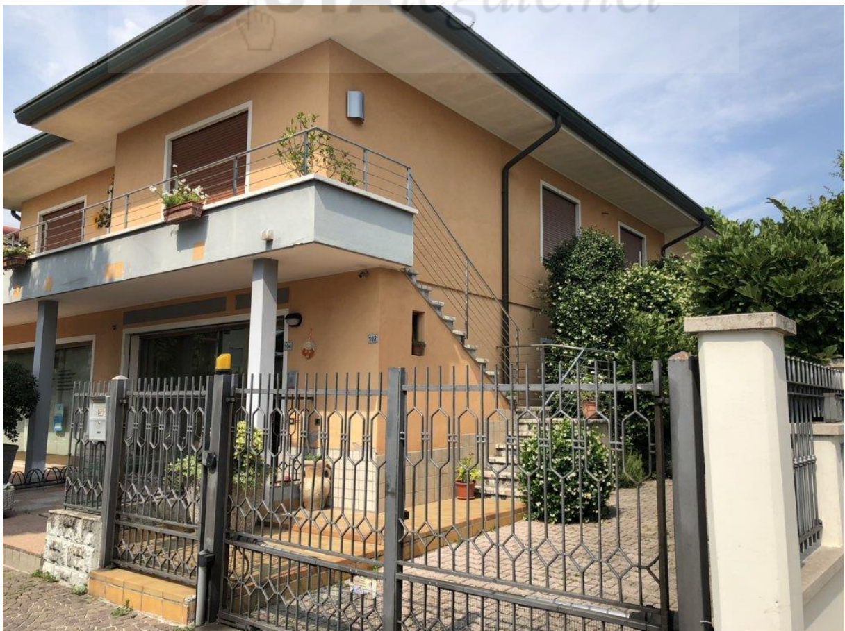
foto n. 2 – angolo sud-ovest del fabbricato
