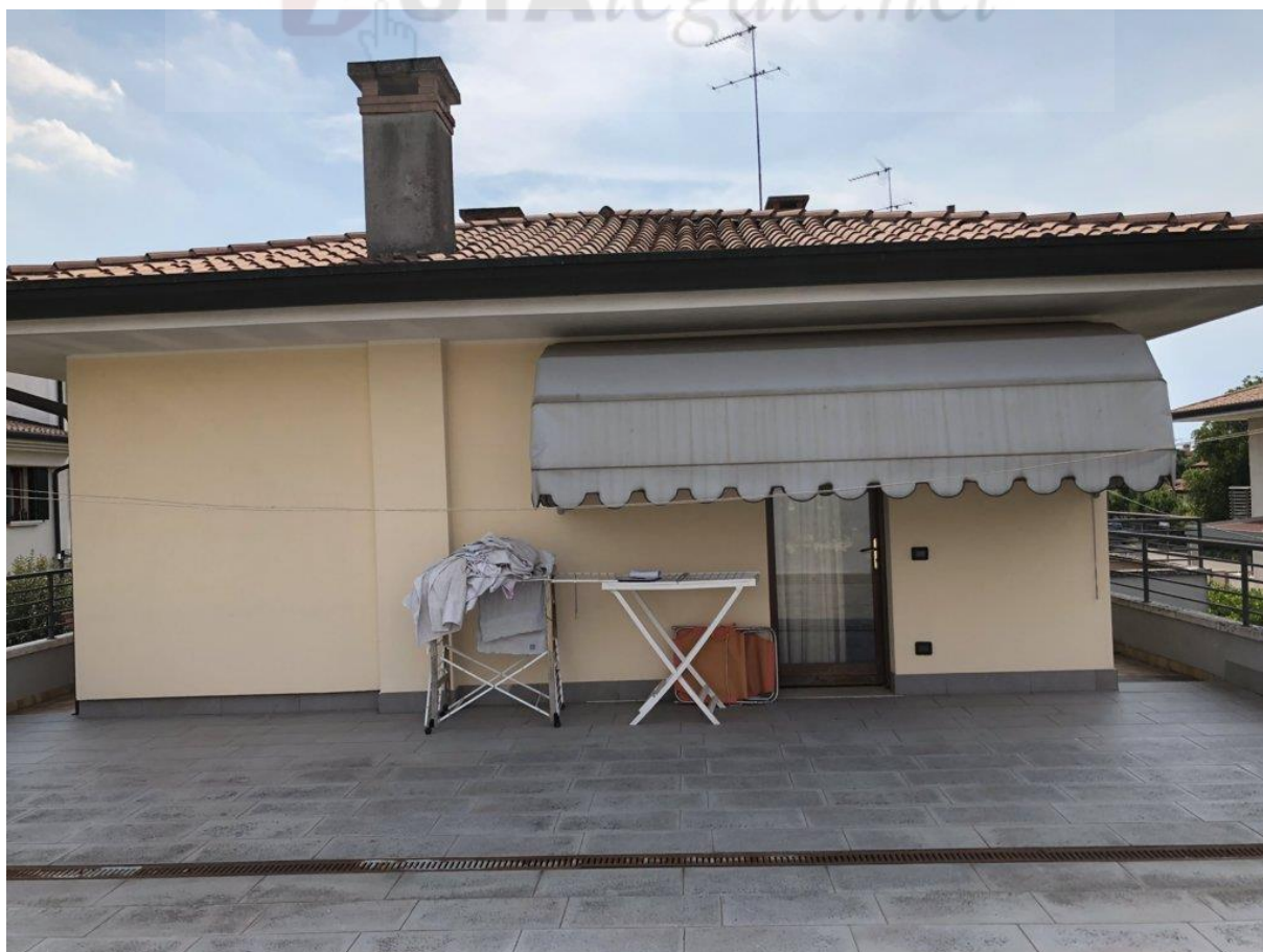
foto n. 16 – terrazza a piano primo
