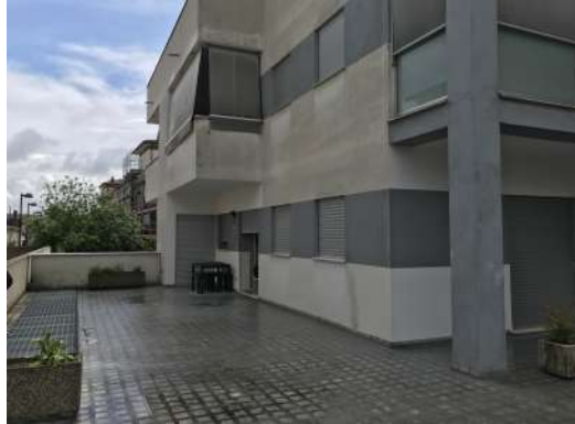
Prospetto sul cortile di proprietà esclusiva
