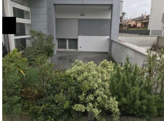
Prospetto su cortile di proprietà esclusiva
