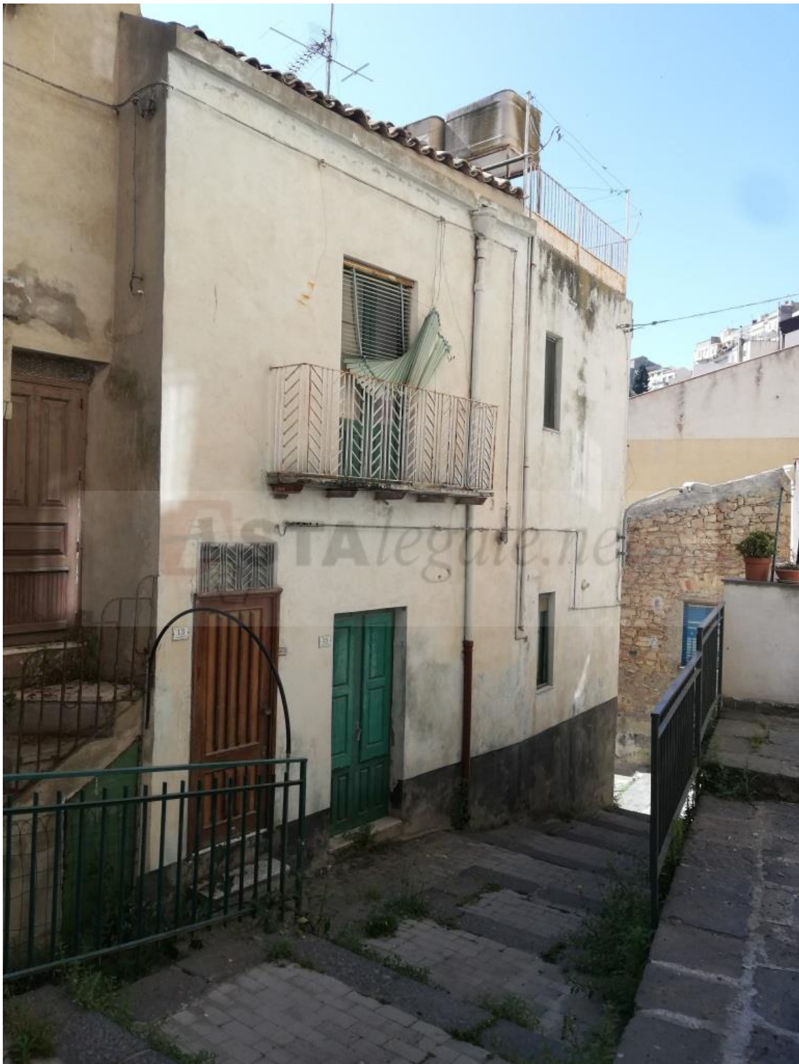
Foto 1 – Prospetto principale del fabbricato
