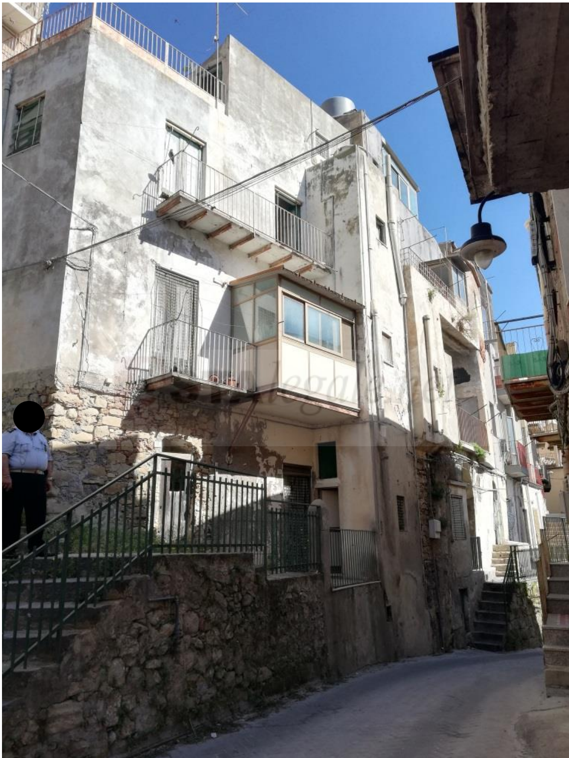
Foto 2 – Prospetto retrostante del fabbricato
