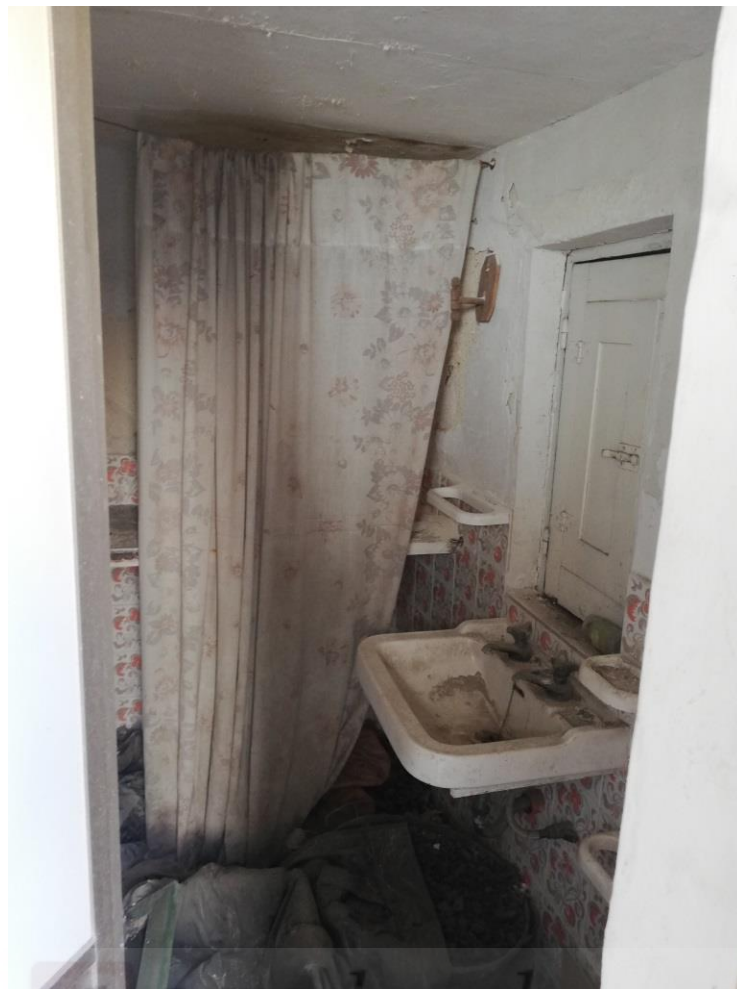
Foto 5 – Interno immobile “B”, bagno
