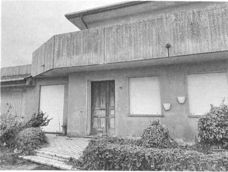
VISTA ESTERNA FRONTE
