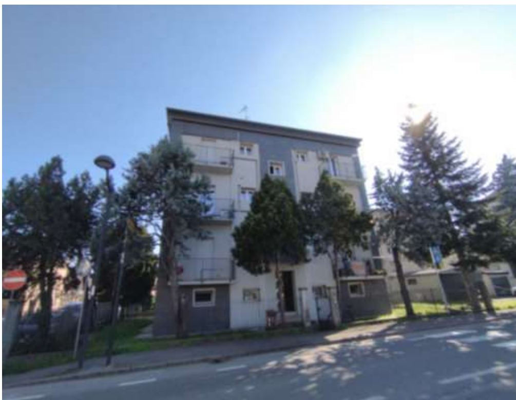
Figura 2: prospetto principale del fabbricato.
