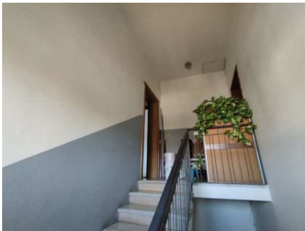
Figura 6: vano scala comune e porta d'ingresso all'appartamento.
