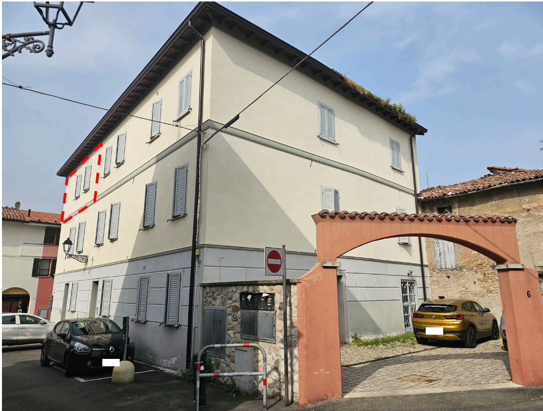
Esterno 4: Vista di insieme – Prospetti sud-ovest – fronti su via del Taglio angolo via San Biagio
