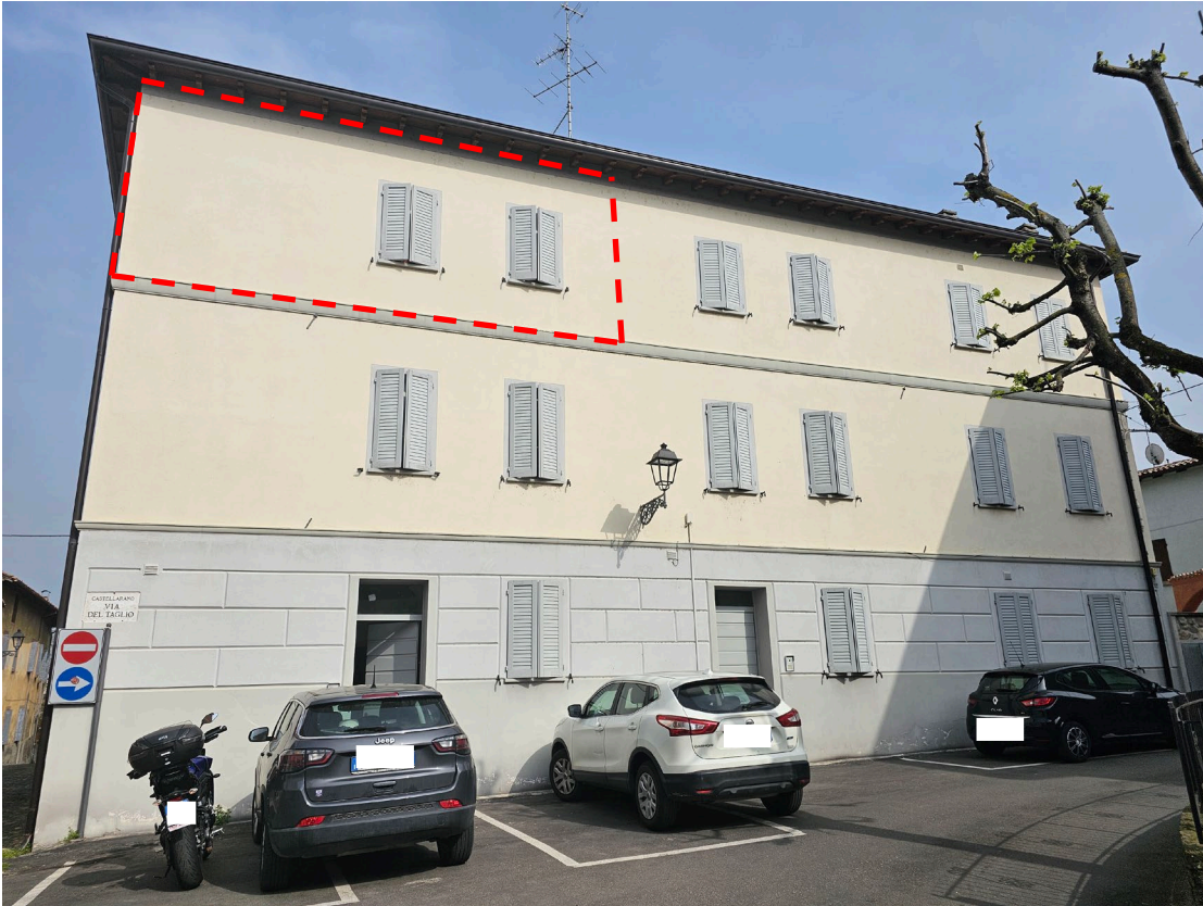
Esterno 1: Vista di insieme – Prospetto ovest su via del Taglio
