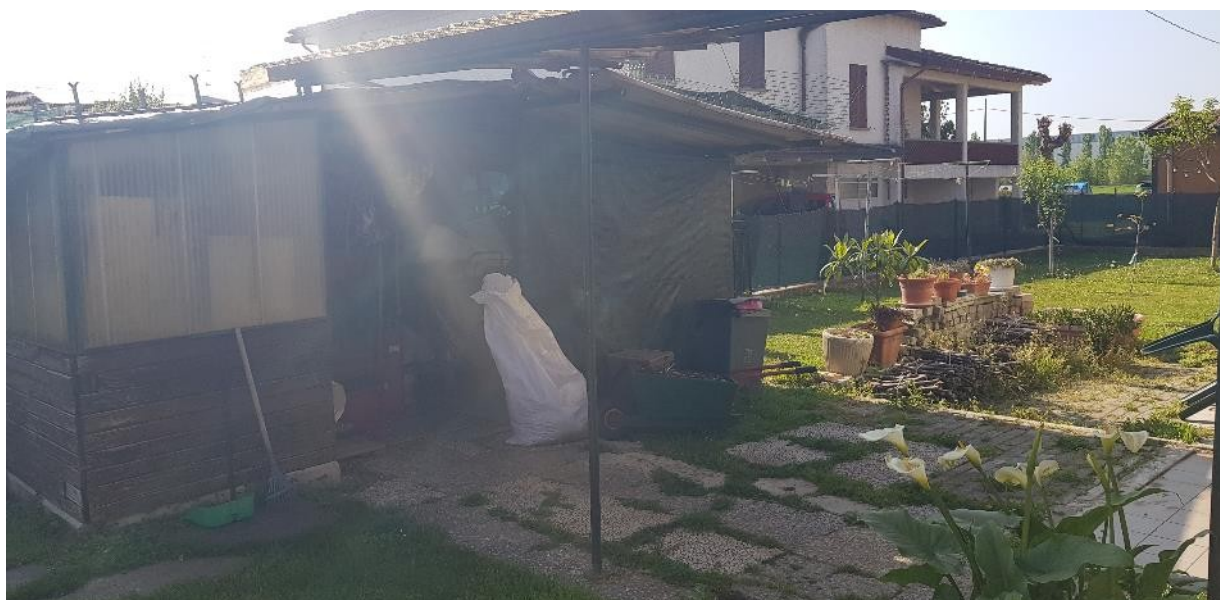
Figura 10: presenza di baraccature nel cortile lato est
