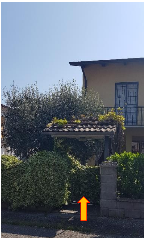
Figura 3: ingresso all'immobile da via Che Guevara
