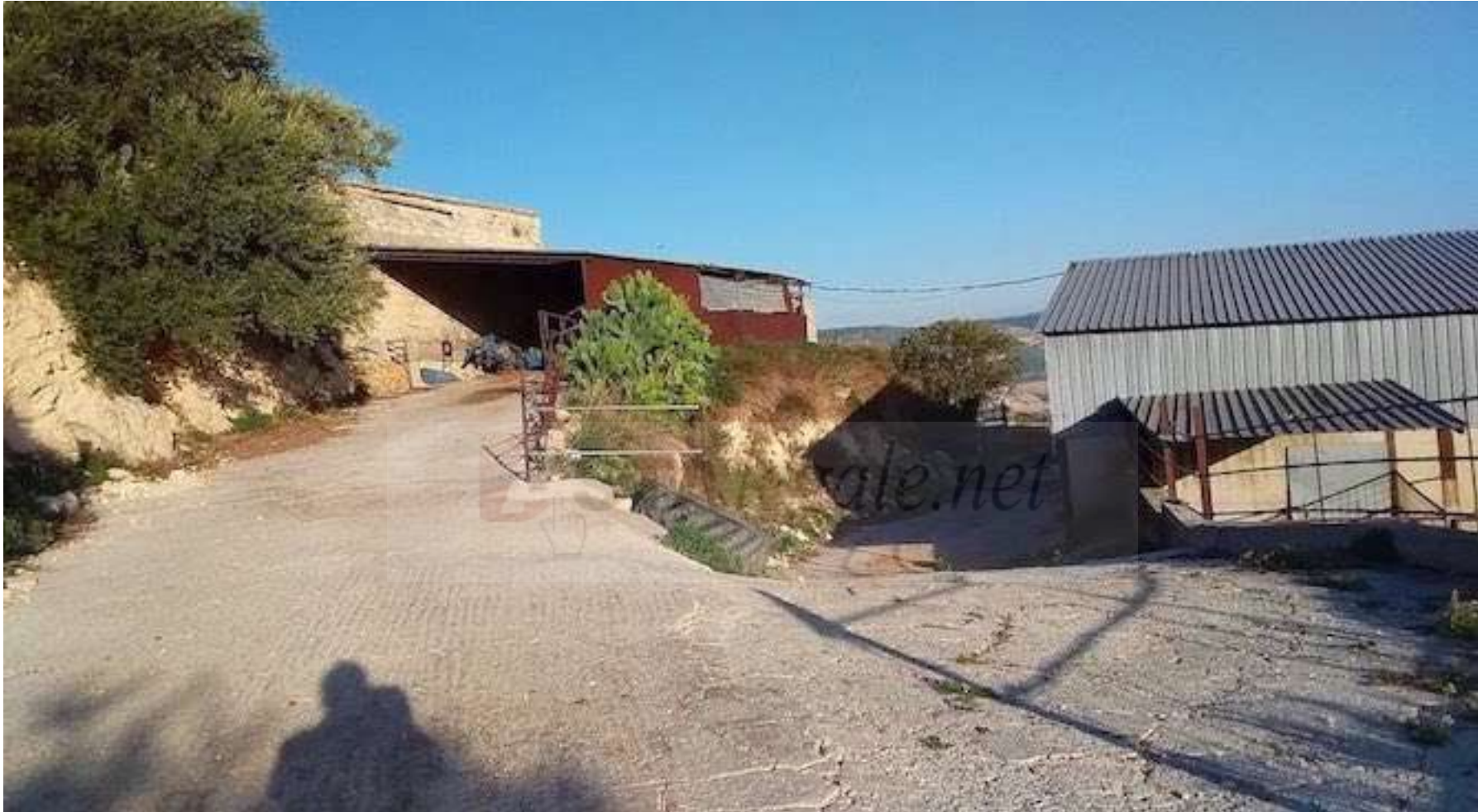
Foto 25 particella 440 tettoie cat D10
