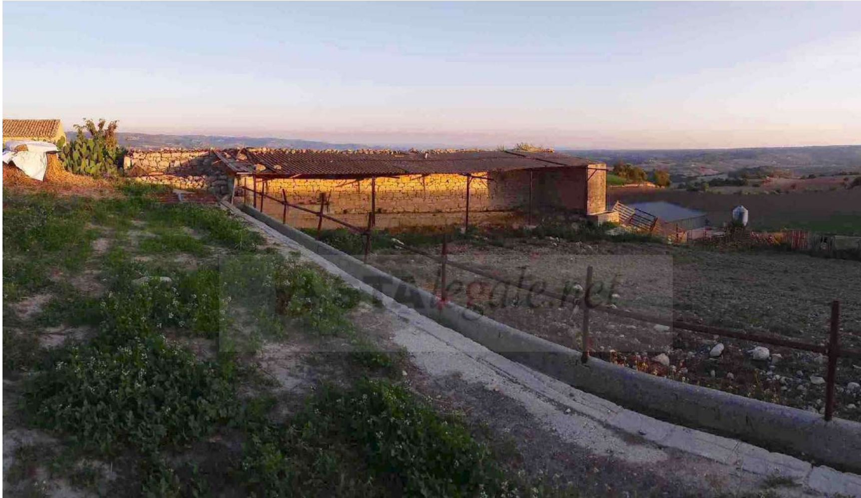
Foto 26 particella 440 tettoie cat D10
