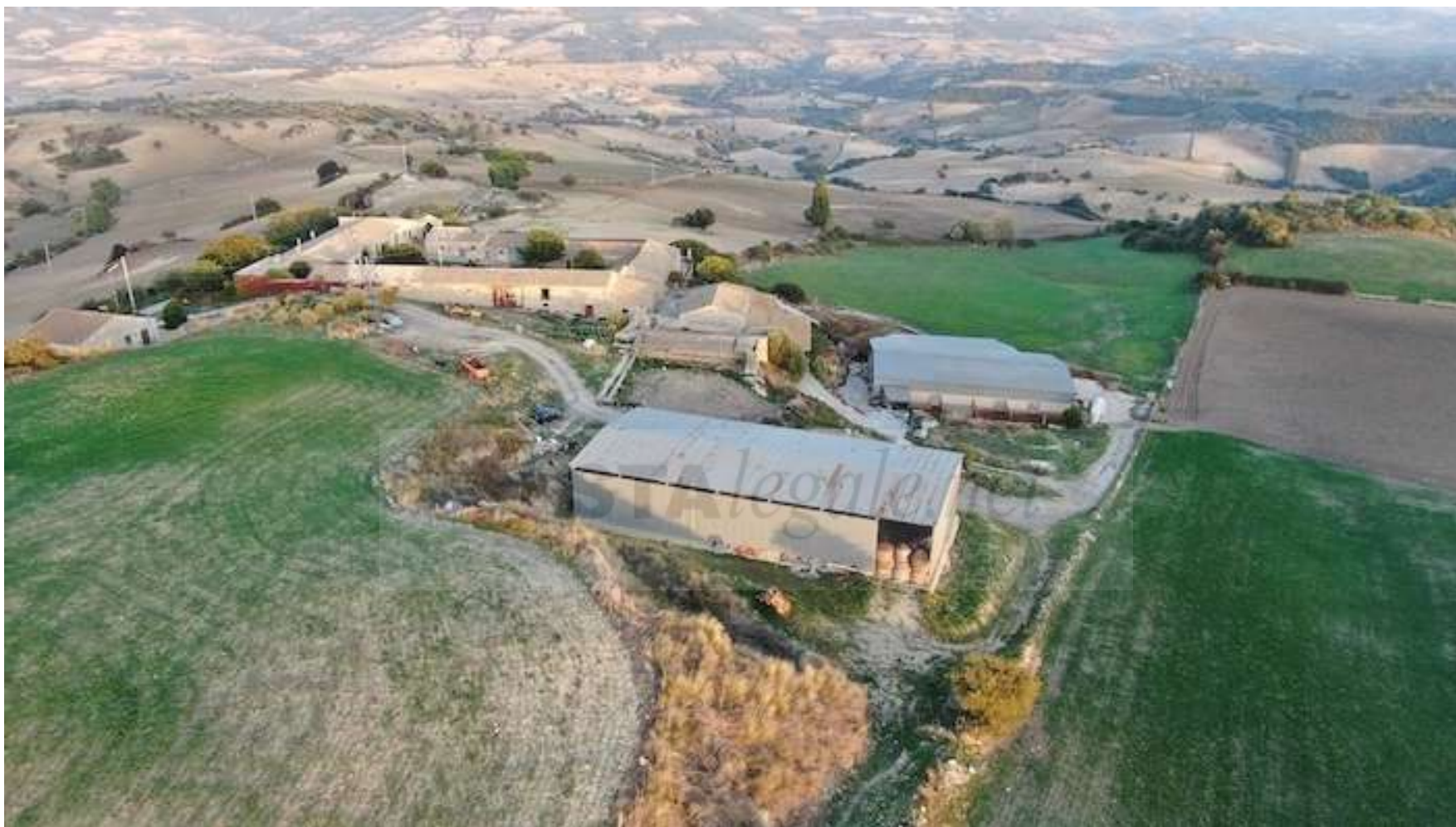
Foto 3 Lotti 1 e 2 panoramica
