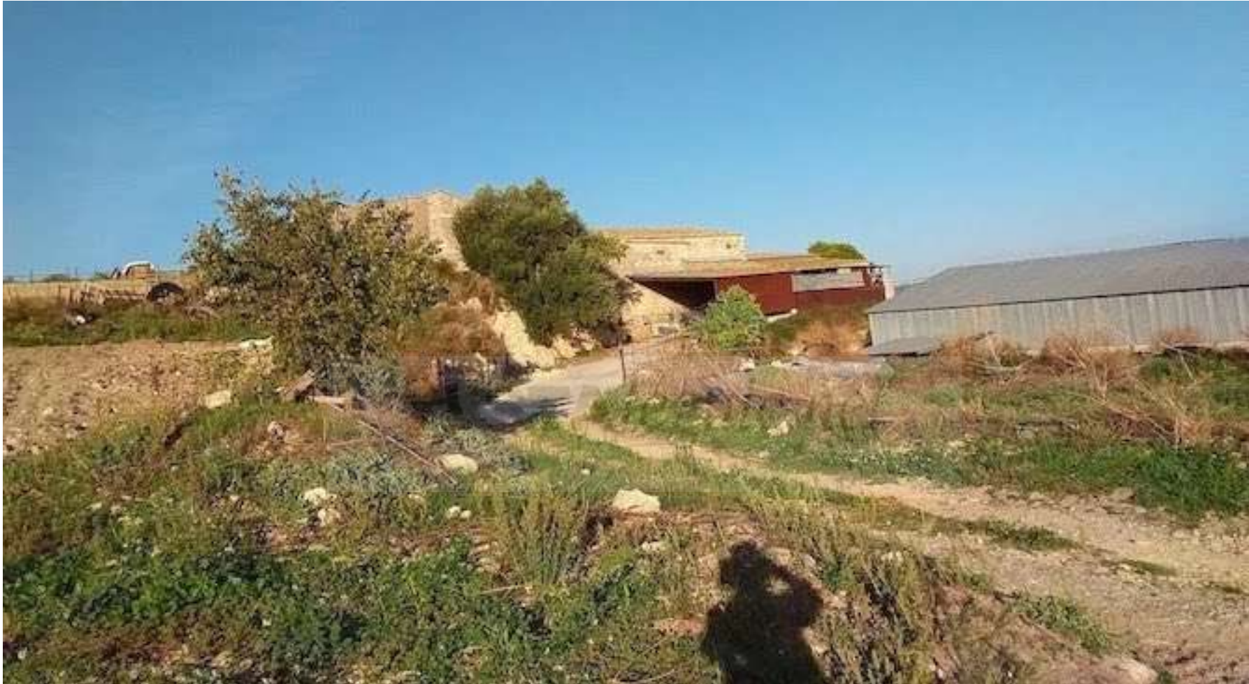
Foto 24 particella 440 tettoie cat D10
