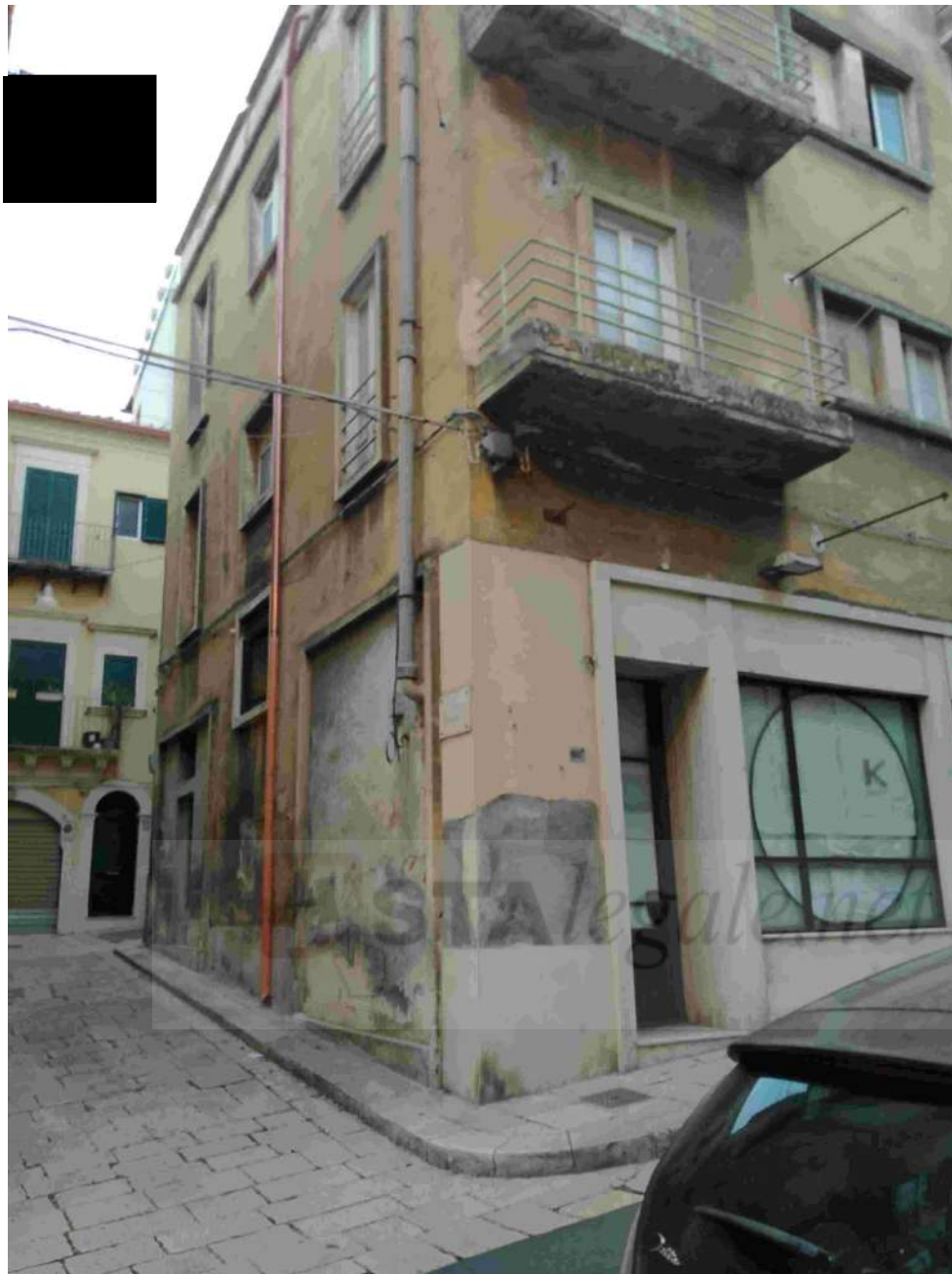
Foto n. 4 – Appartamento al primo piano, lato corso Vittorio Veneto.
