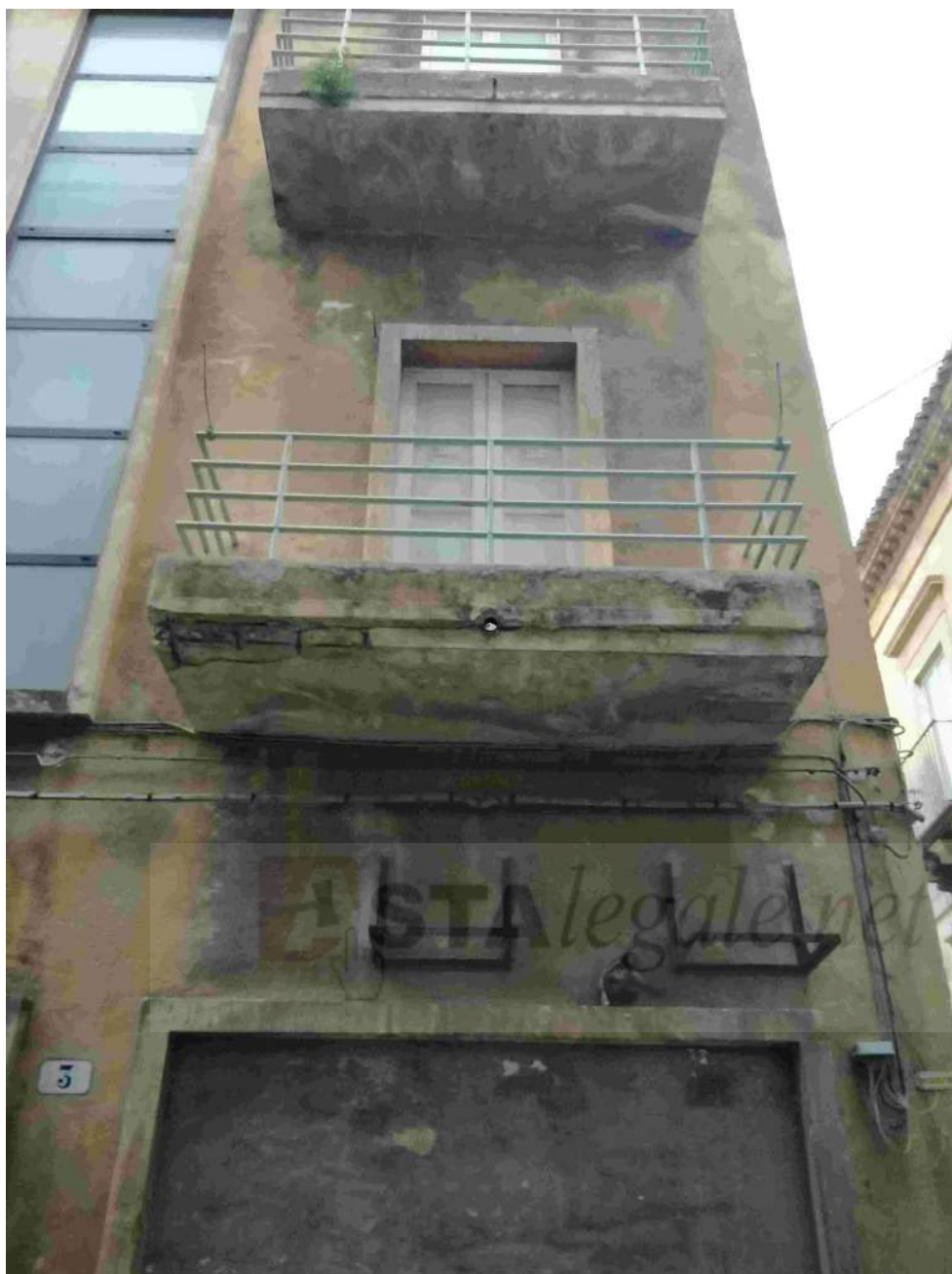
Foto n. 3 – Appartamento al primo piano, lato via Xiumè.
