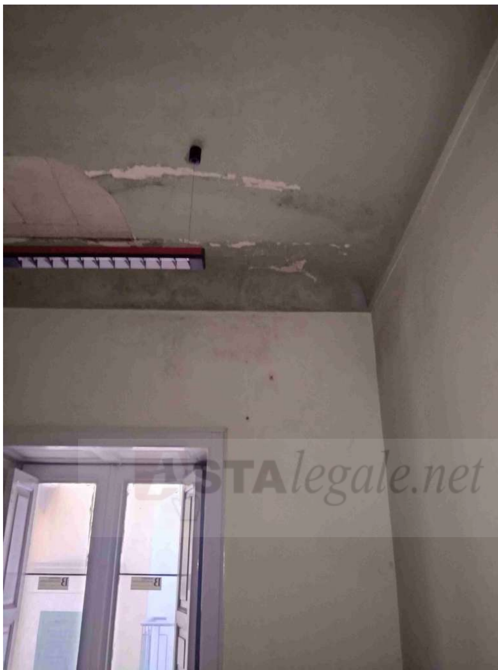
Foto n. 14 – Infiltrazioni acqua 1.
