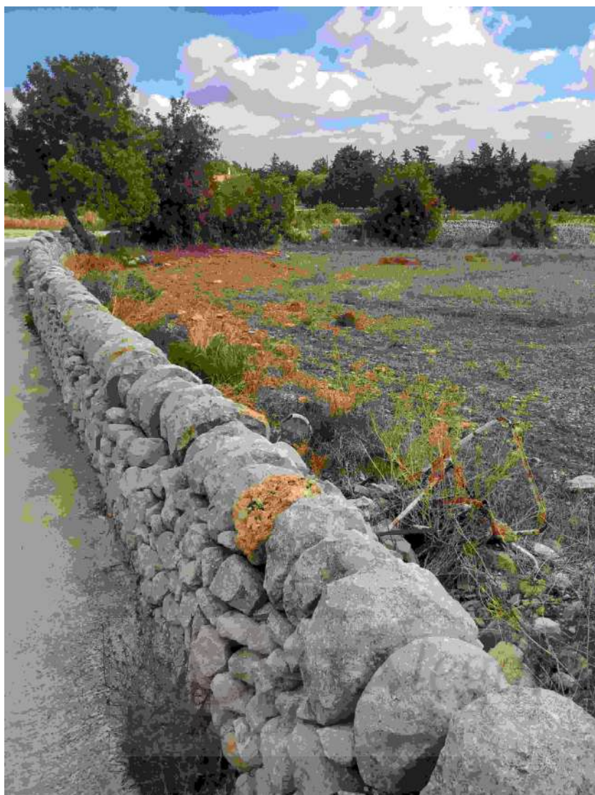
Foto n. 30 – Vista confine lato Nord con muro a secco.
