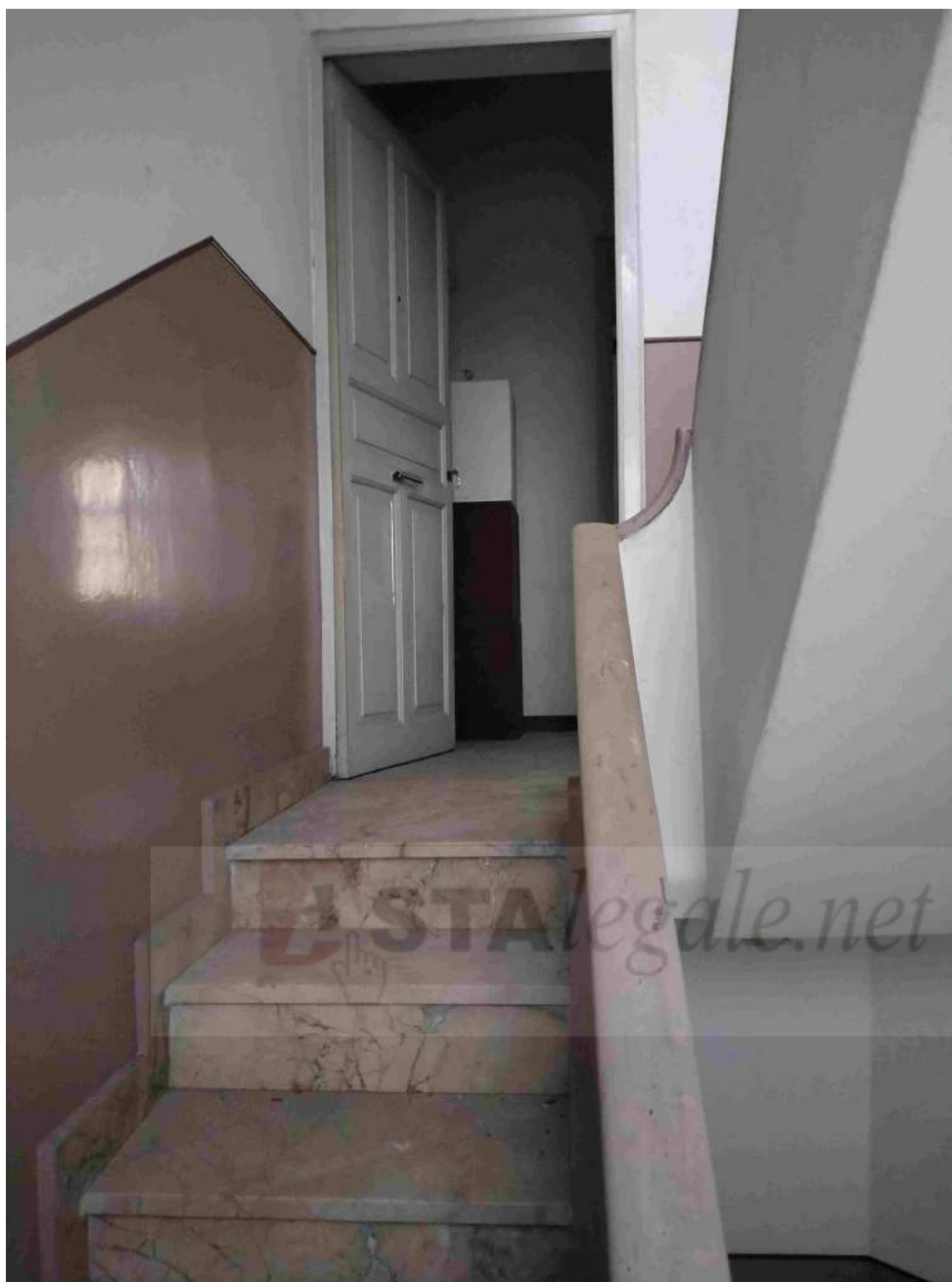
Foto n. 5 – ingresso appartamento con scala in marmo..
