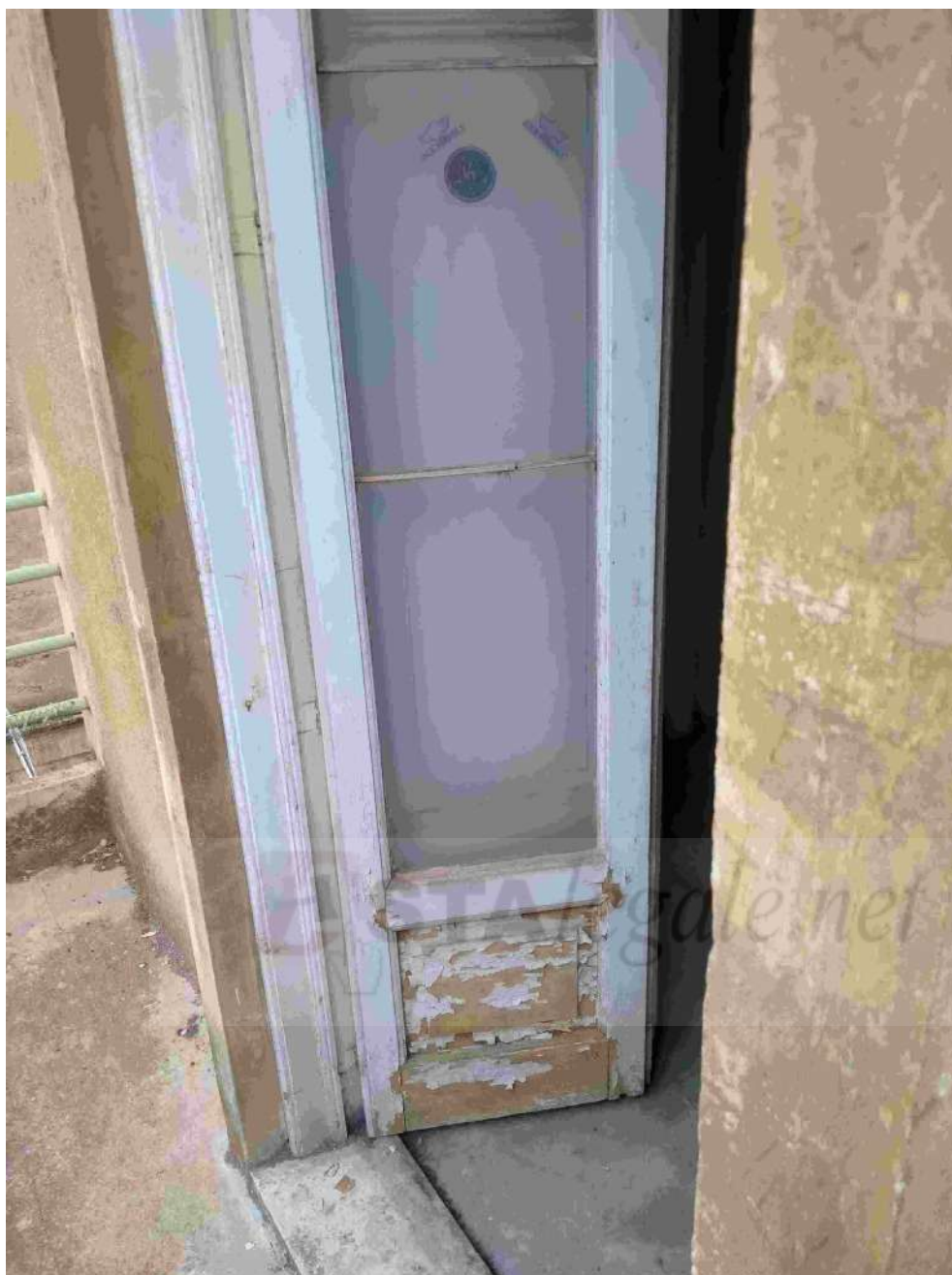
Foto n. 18 – Infissi esterni in legno e vetro.
