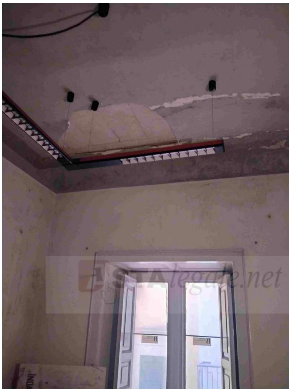
Foto n. 15 – Infiltrazioni acqua 2.
