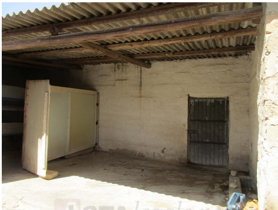
Foto 9 – Blocco A – porta accesso p.lla 817
