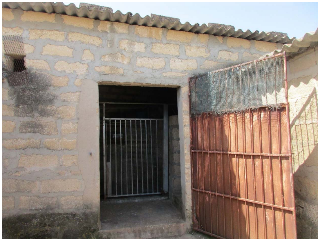
Foto 12 – Blocco B - accesso
