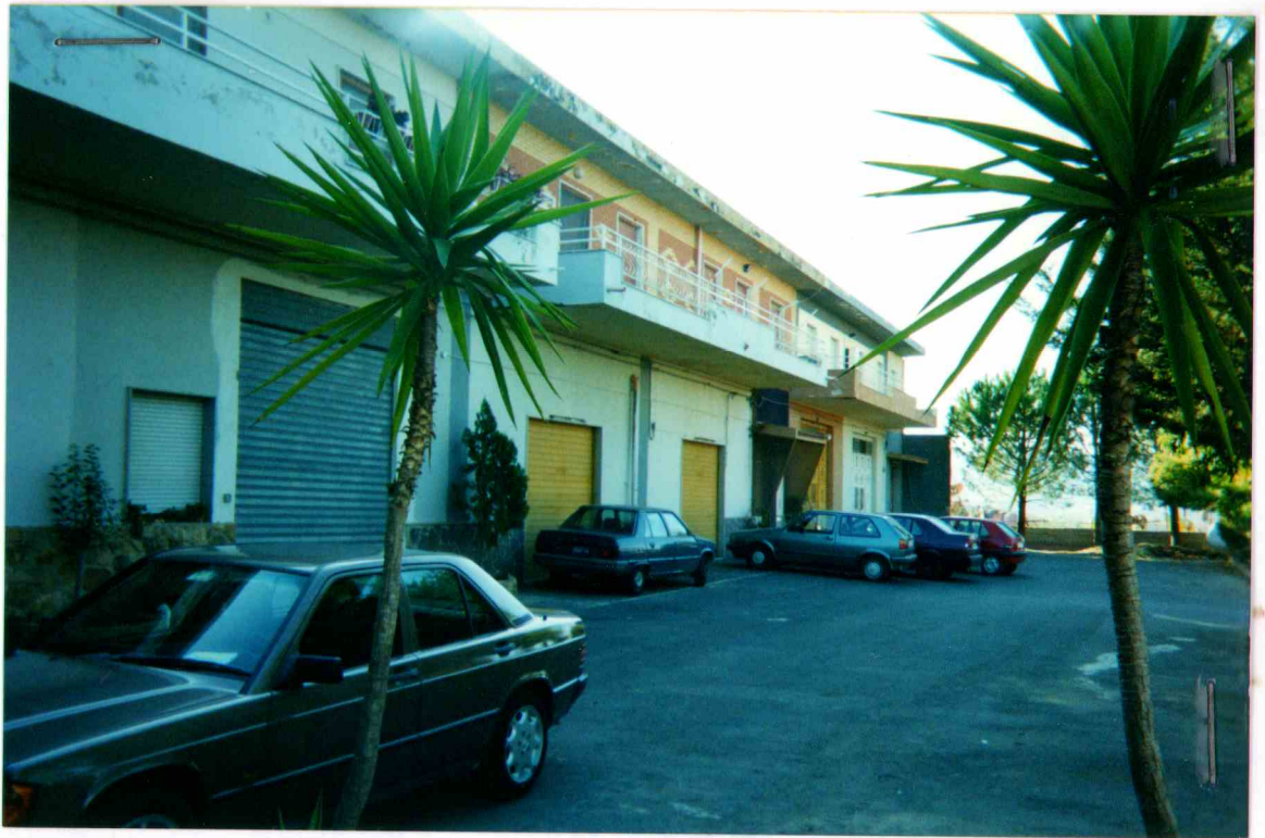
VISTA DALLA CORTE DEL PROSPETTO PRINCIPALE
