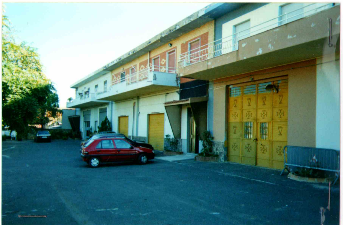
VISTA DALLA CORTE DEL PROSPETTO PRINCIPALE
