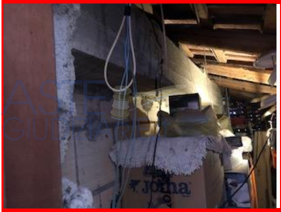
Foto 11 – Locale di sgombero sottotetto.
