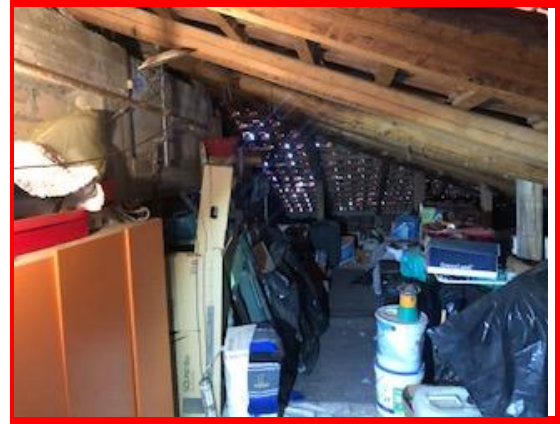
Foto 12 – Copertura locale di sgombero sottotetto.
