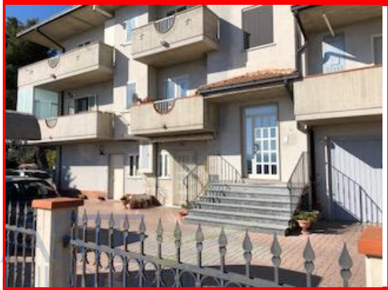
Foto 1 - Lato esterno fabbricato.
