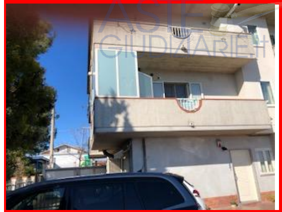
Foto 2 - Balcone parzialmente chiuso dell'immobile.
