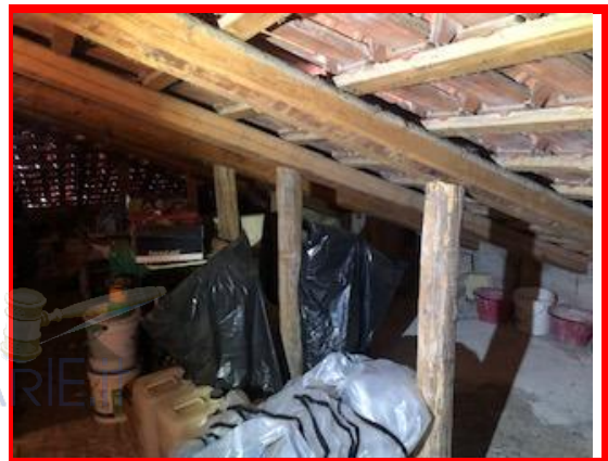
Foto 4 - Locale di sgombero struttura portane copertura con falsi appoggi.
