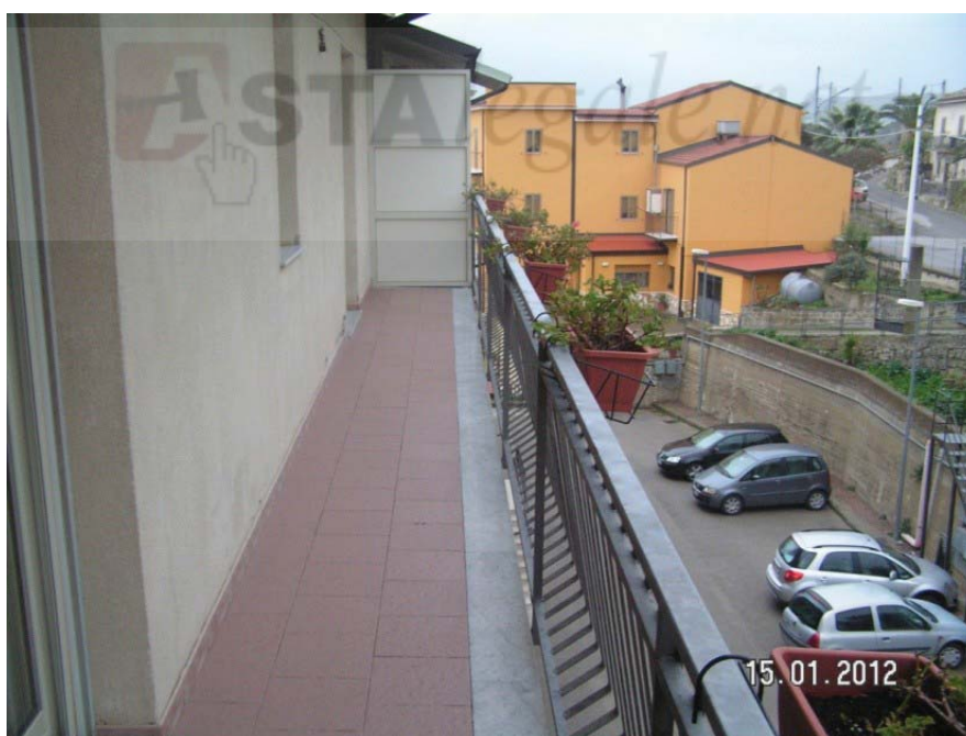
Figure VI – Balcone relativo al prospetto di monte con accesso dal vano soggiorno con relativa corte di pertinenza del fabbricato
