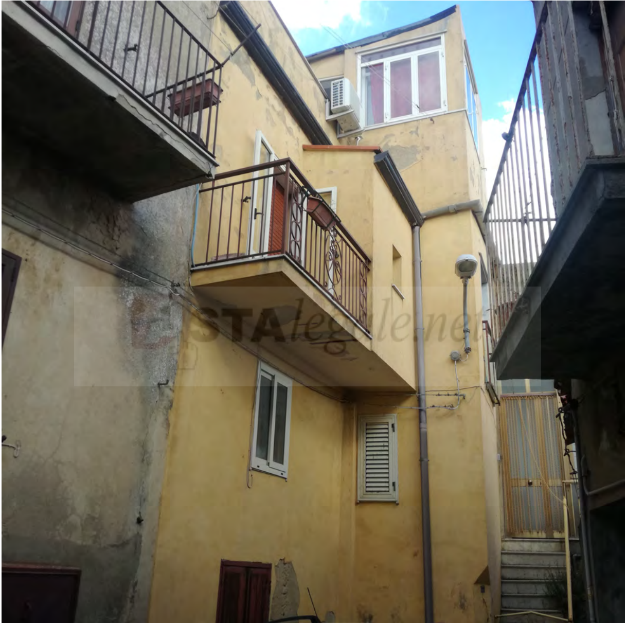
Foto n. 2 - Vista esterna dalla via San Biagio del fabbricato oggetto di pignoramento
