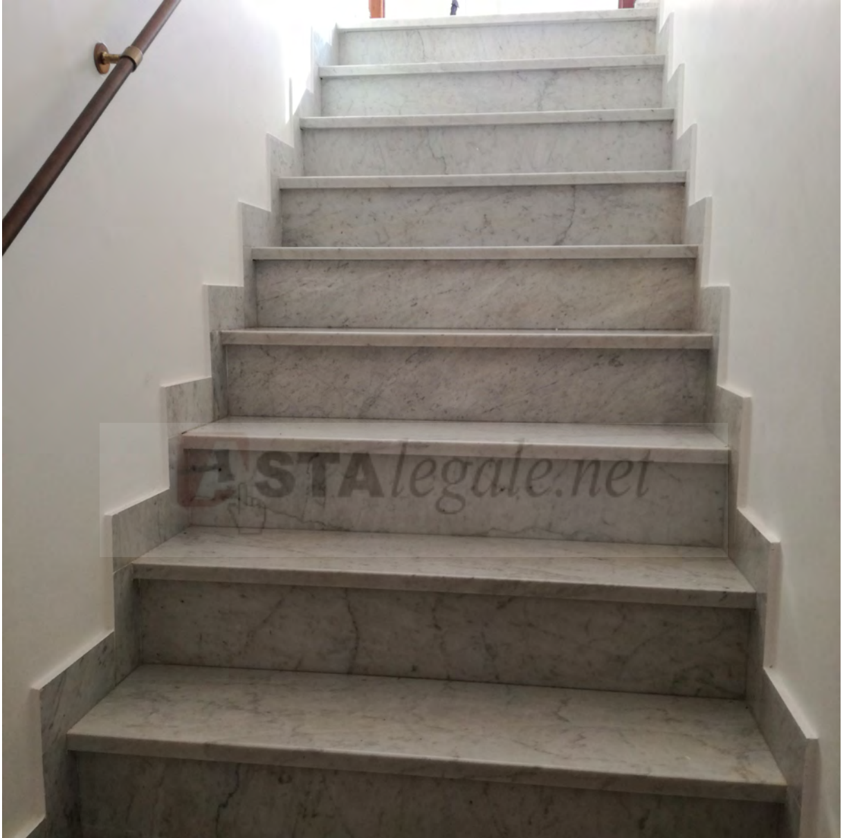
Foto n. 10 - Vista della scala interna che dal piano primo conduce al piano secondo-terrazzo del fabbricato oggetto di pignoramento
