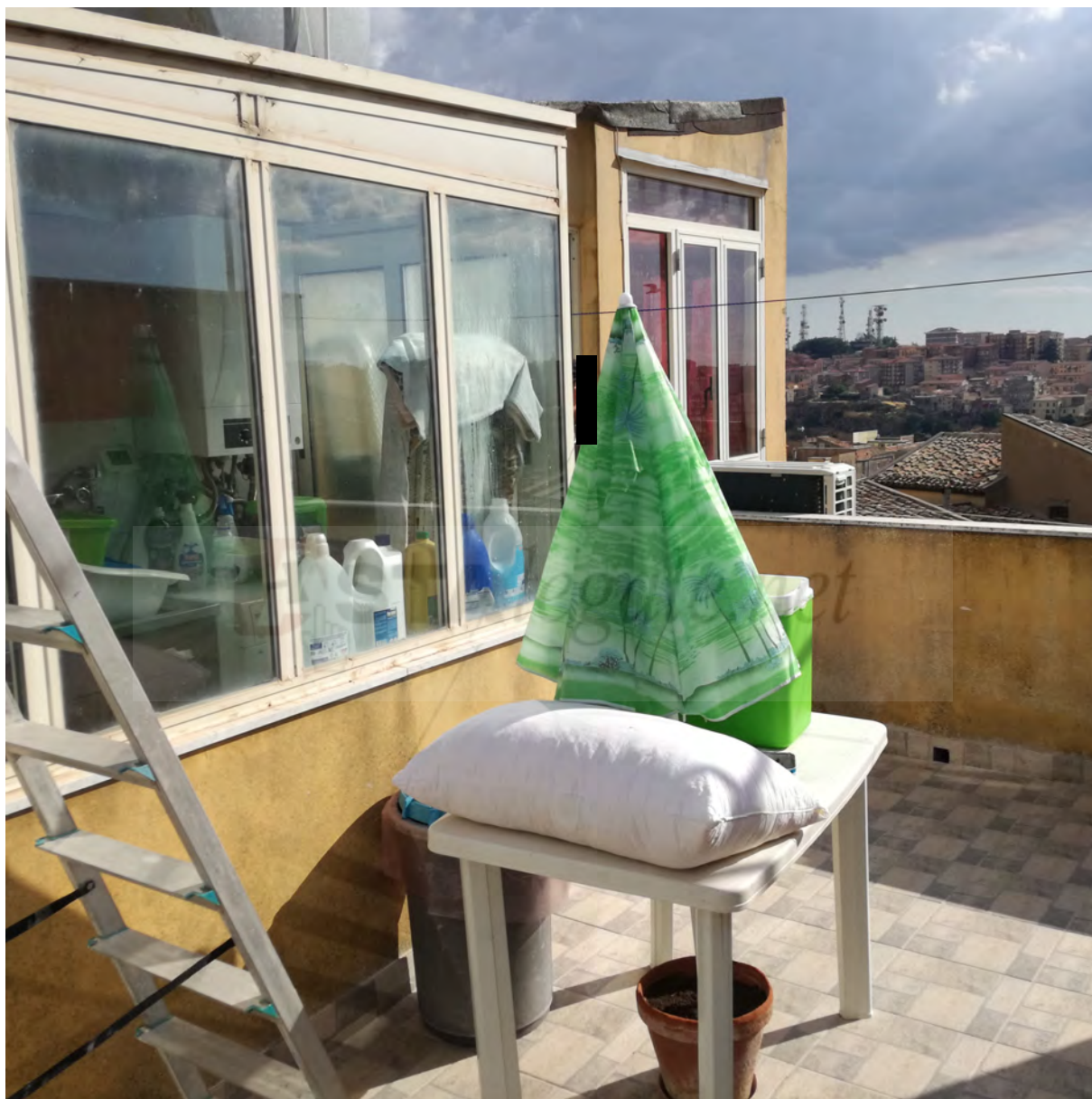
Foto n. 15 - Vista del terrazzo al piano secondo del fabbricato oggetto di pignoramento
