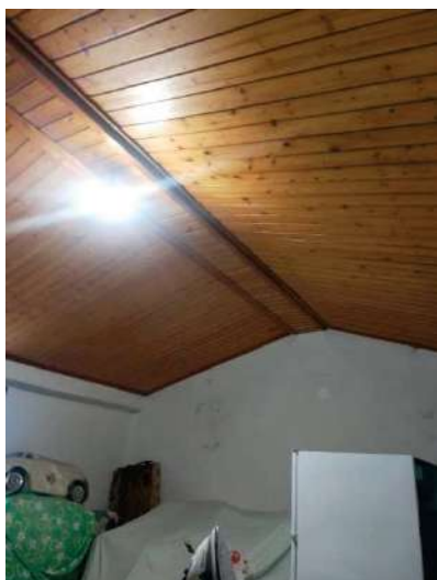
(Foto n.8_ vano piano secondo)
