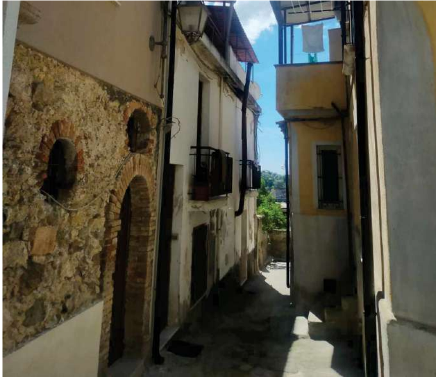
(Foto n.1_Immobile vista lato sud-ovest)
