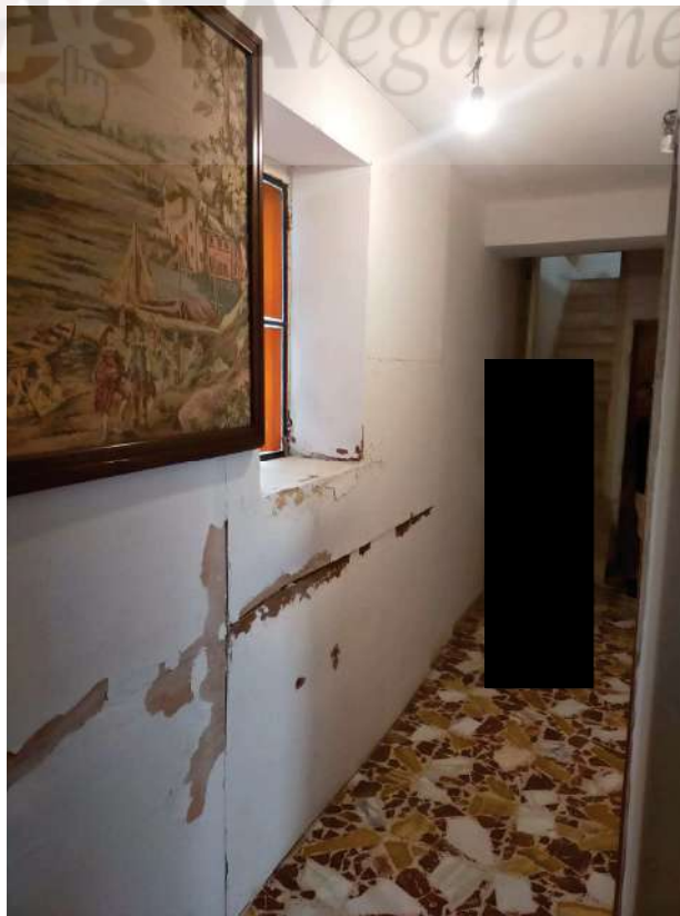
(Foto n.8_ corridoio e scala interna di accesso al piano secondo)
