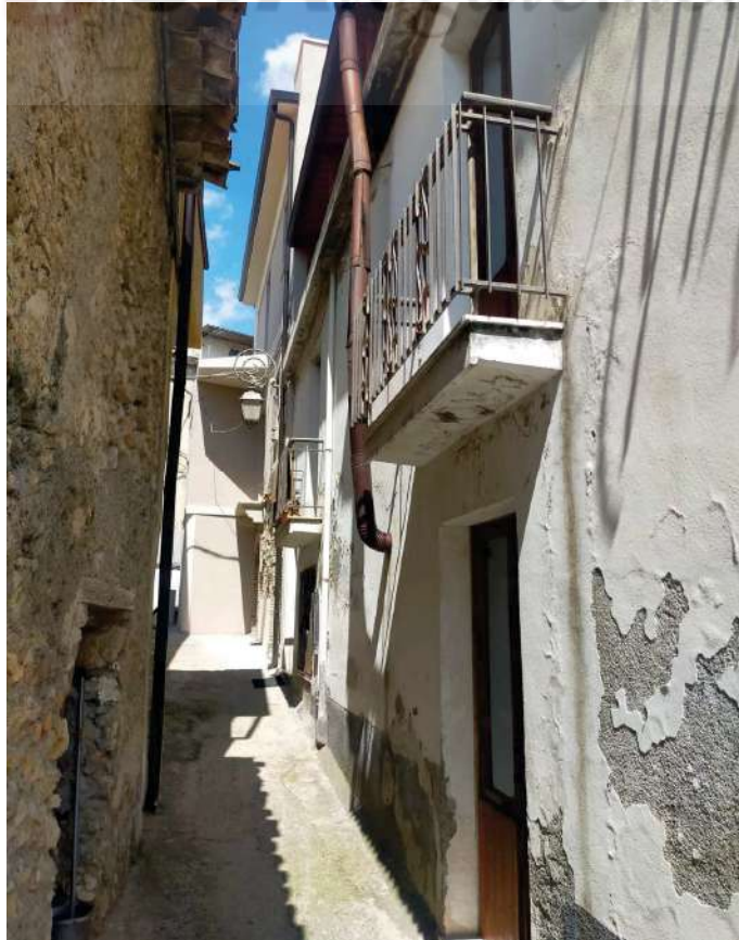
(Foto n.2_Immobile vista lato sud-ovest)
