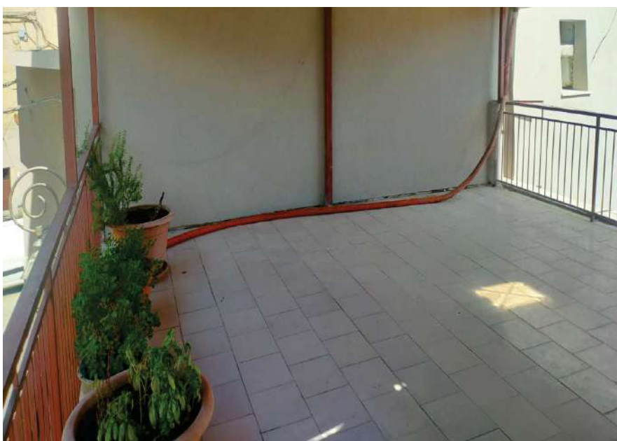
(Foto n.10_ balcone-veranda piano secondo)
