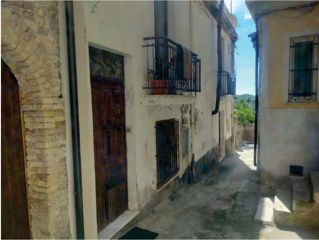
(Foto n.3_Immobilabile lato sud-ovest - ingresso)
