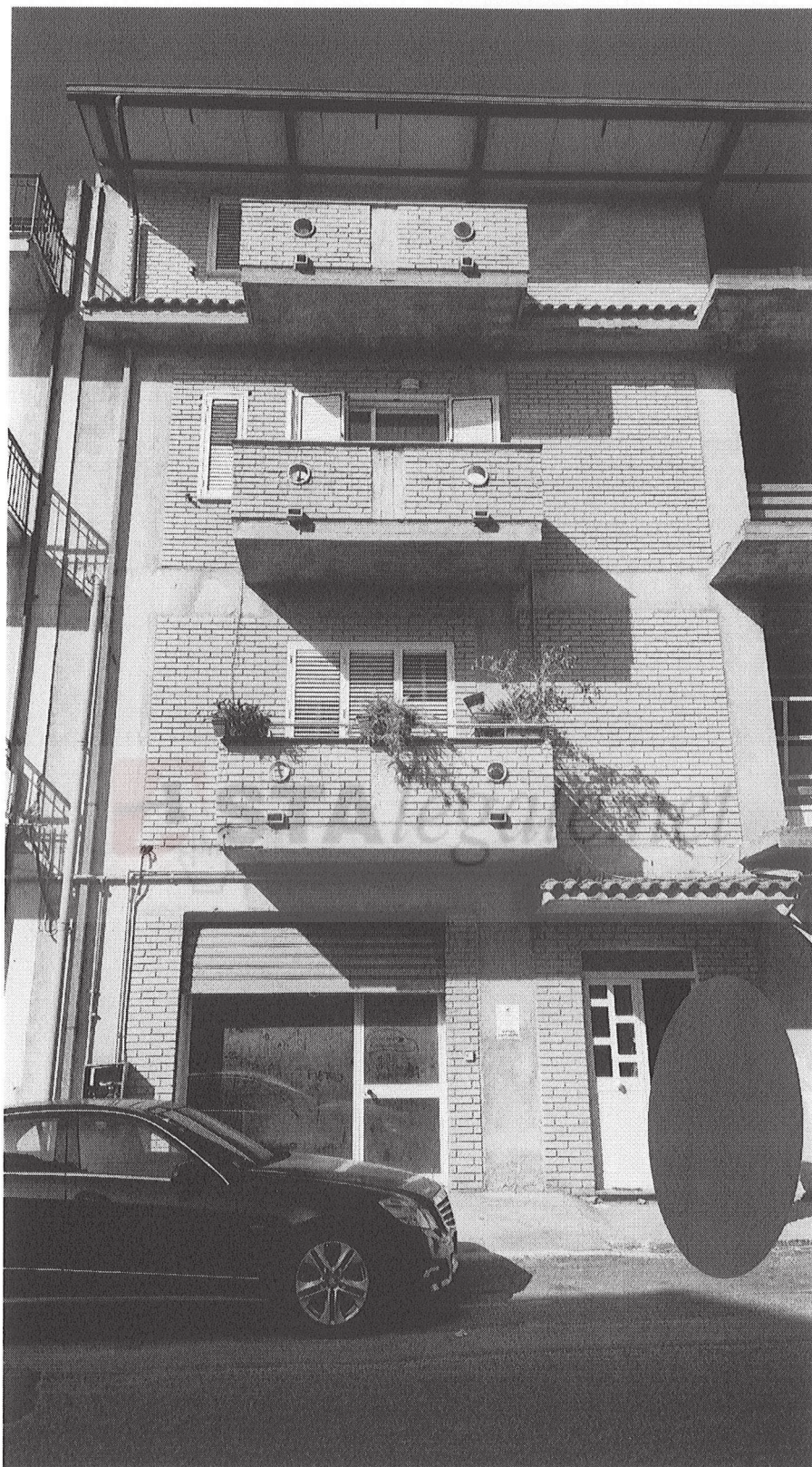
Foto n. 1 - prospetto su via Trieste
